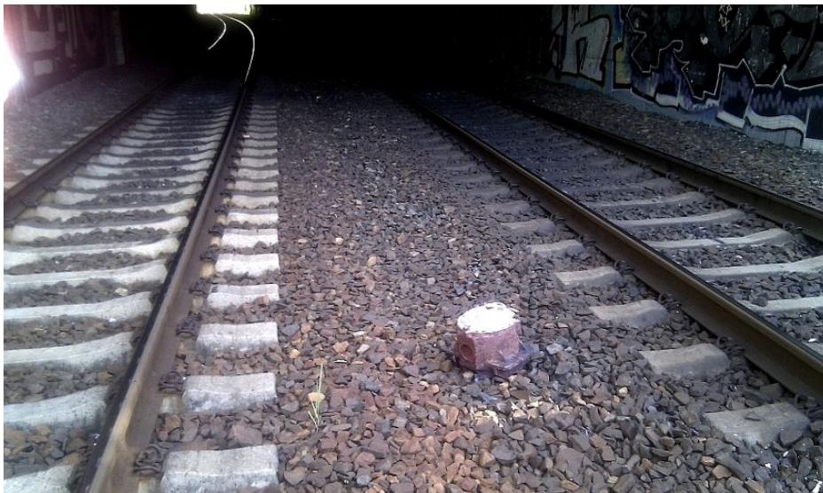
Obr. č. 1: Ložiskový domek TDV č. 33 54 7854 152-7, nalezený v km 173,579
