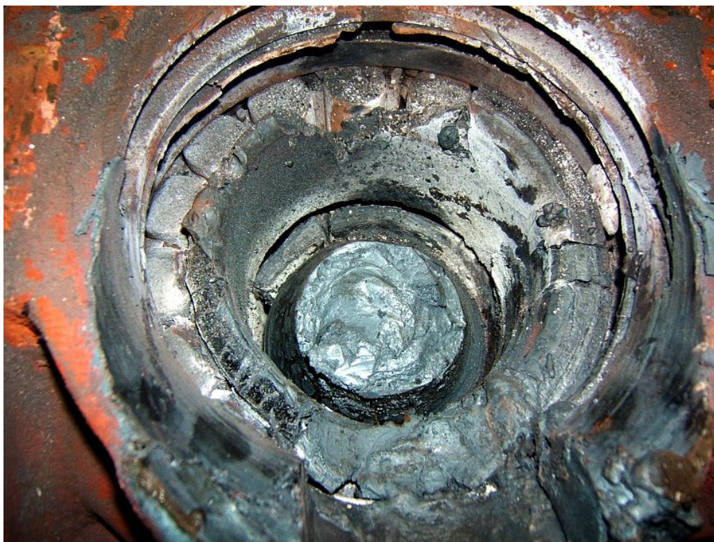
Obr. č. 7: Detail zadřené ložiska
