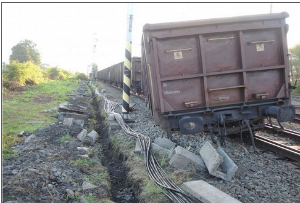
Obr. č. 1: Celkový pohled na druhé vykolejené TDV řazené jako 35. TDV za HDV.
