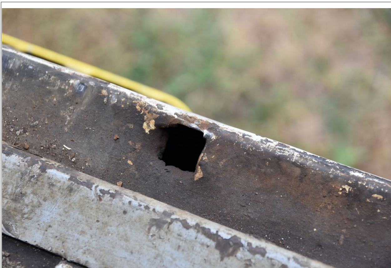
Obr. č. 5: Stav dolního otvoru pro čep v rámu pravých dveří HDV 854.030-4
