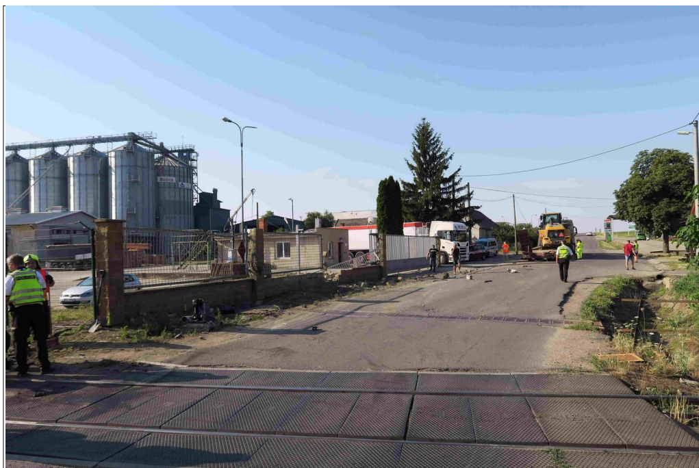
Obr. č. 7: Pohled na poškození oplocení a zastavení NA s návěsem
