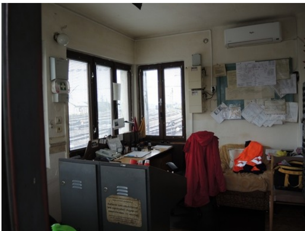
Obr. č. 4: Pohled do místnosti stavědla St 3 ve směru na ONA
