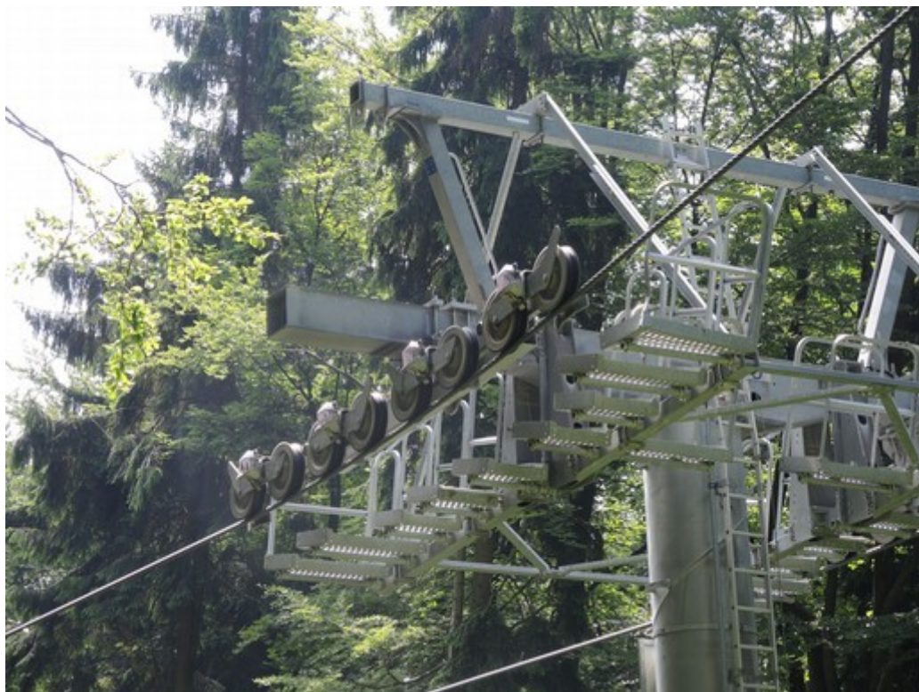
Obr. č. 5: Detail kladkové baterie vratné větve podpěry č. 9
