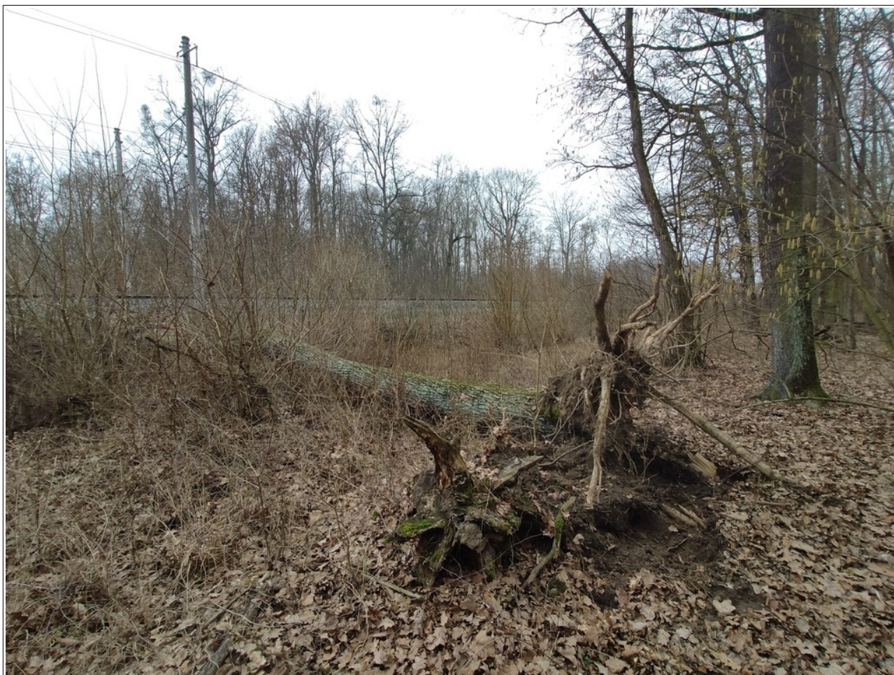
Obr. č. 8: Pohled na kořenový bal a část kmene stromu rostoucího na pozemku p. č. 1029 vyvráceného v km 69,426 přes obě TK mezistaničního úseku Štěpánov – Červenka
