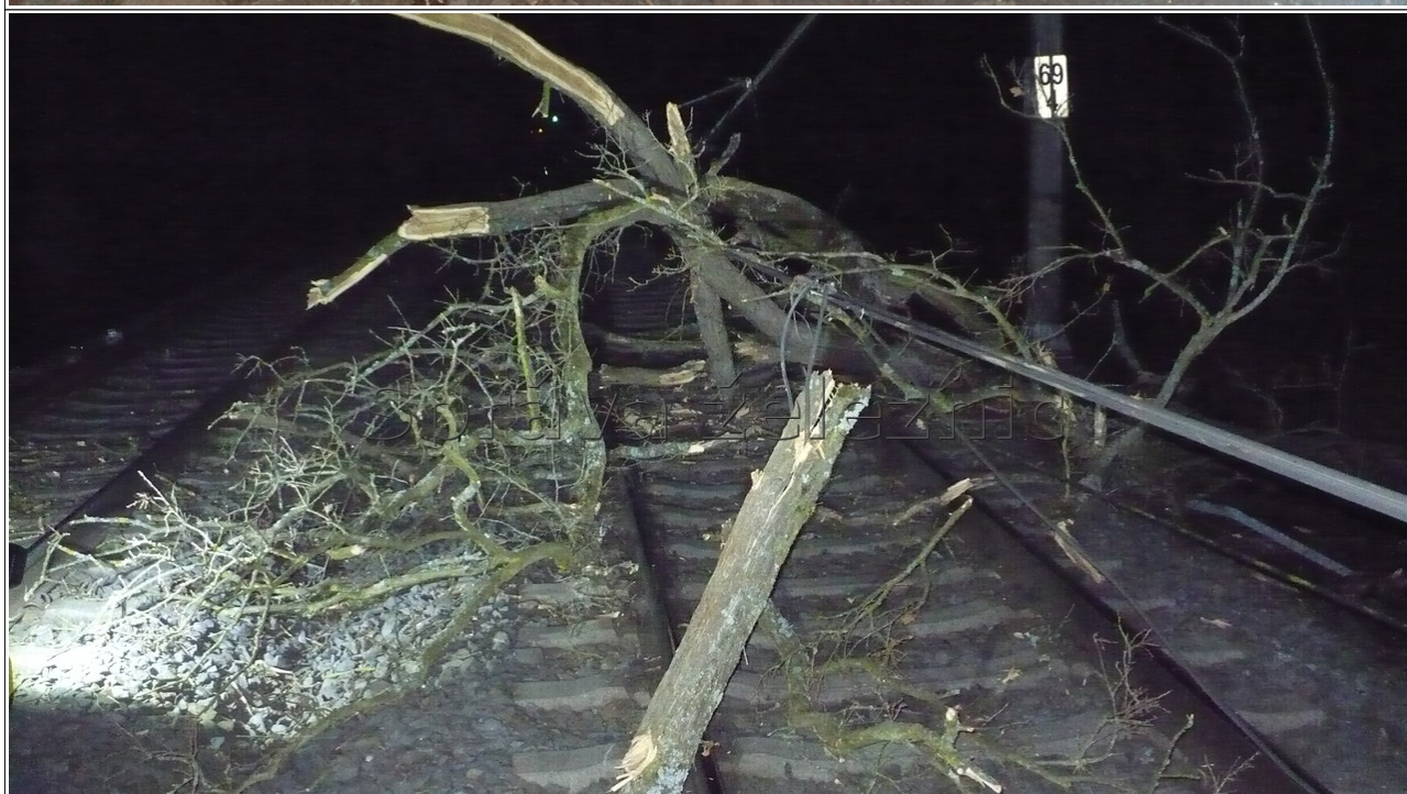
Obr. č. 6, 7: Část koruny a kmene stromu vyvráceného v km 69,426 přes obě TK mezistaničního úseku Štěpánov – Červenka z pozemku p. č. 1029
