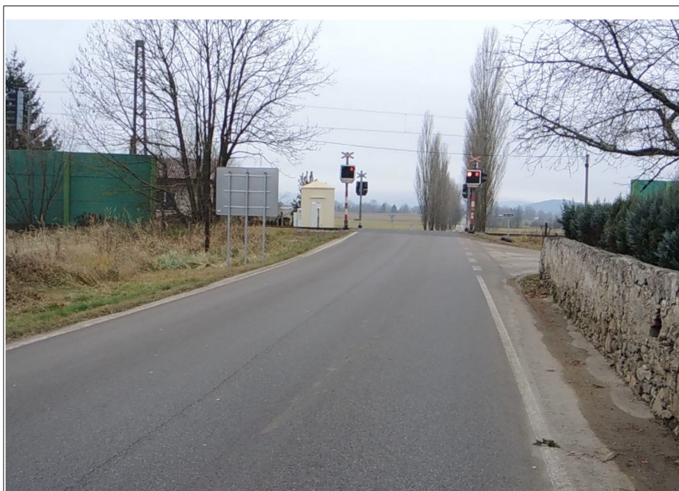
Obr. č. 2: Viditelnost světelné výstrahy ve směru jízdy OA ze vzdálenosti 45 m
