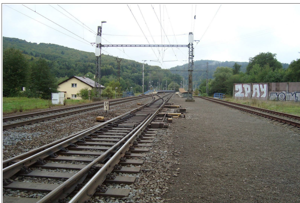
Obr. č. 4: Pohled na výhybky č. 15, 16 na krasíkovském zhlaví žst. Hoštejn v době po MU před zrušením nouzového závěru. Zdroj: SŽ
