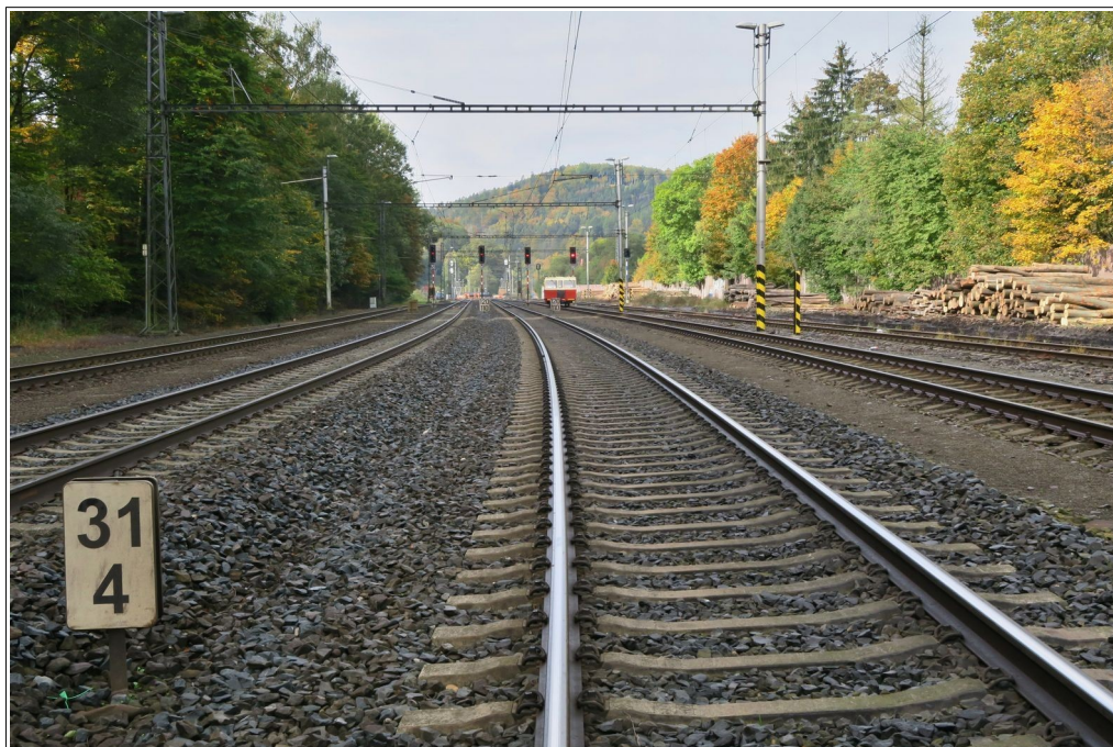
Obr. č. 3: Pohled směrem na krasíkovské zhlaví žst. Hoštejn s odjezdovými návěstidly L1, L2, L3 a L4 ze směru od výpravní budovy. Zdroj: DI
