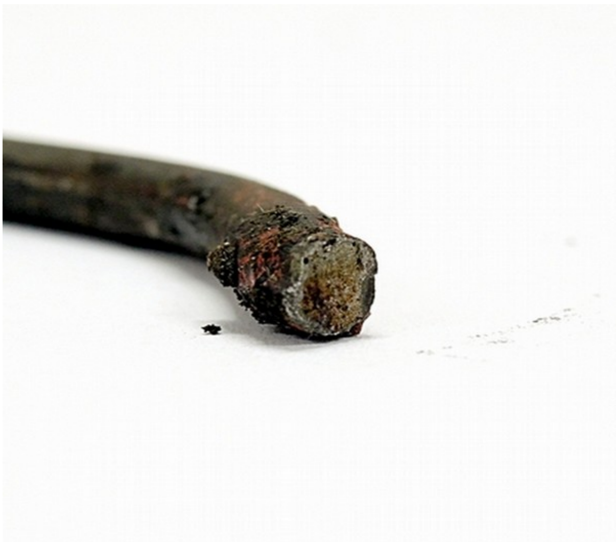
Obr. č. 9: Detail lomové plochy přetrženého drátovodu - 2
