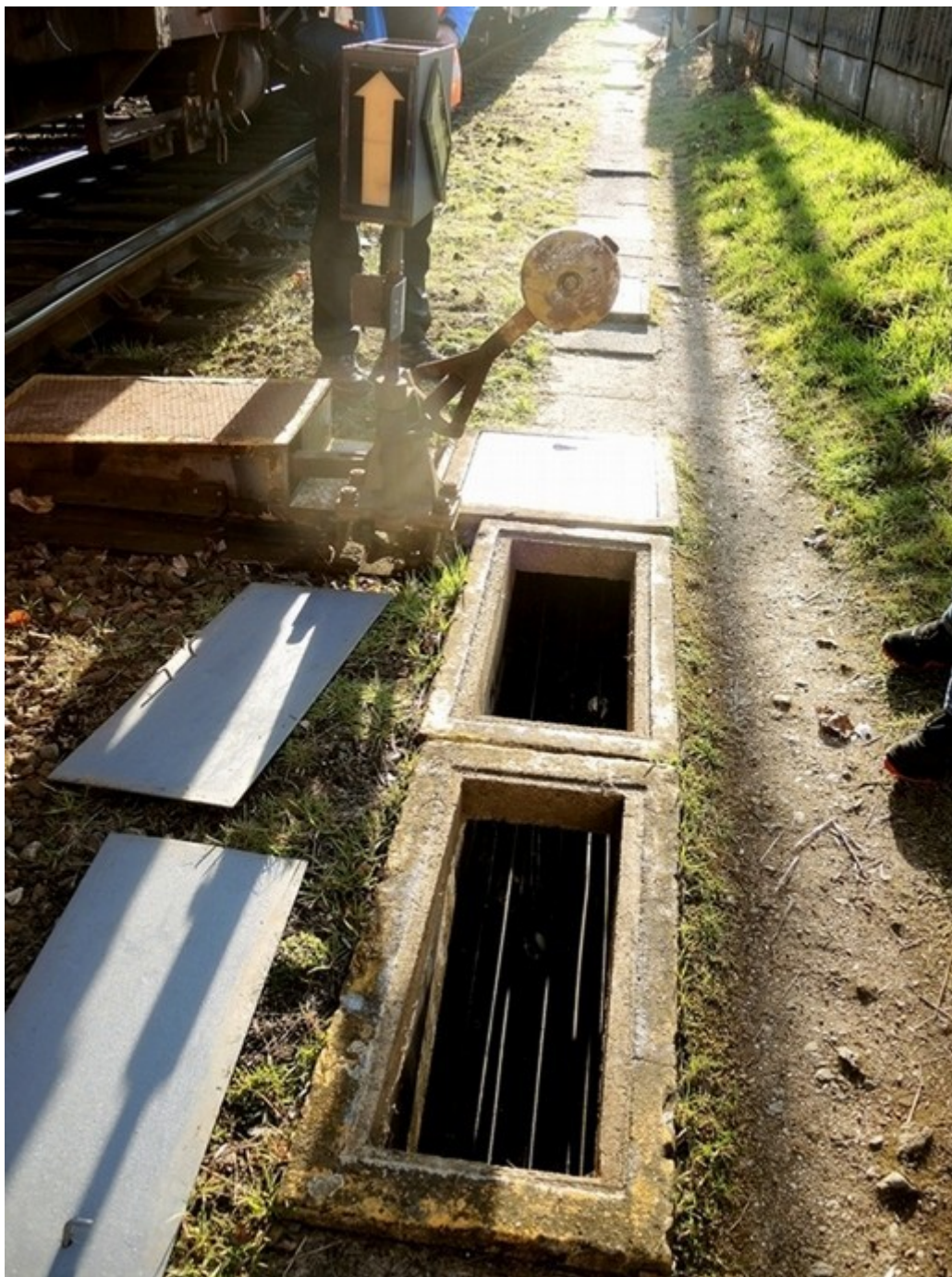
Obr. č. 4: Výhybka č. 34 postavená do přímého směru na SK. č. 13
