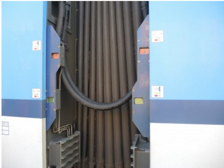
Obr. č. 6: Ukazatele stavu zabrzdění po přezkoušení účinku střadačové brzdy (červená clonka – zabrzděno)
