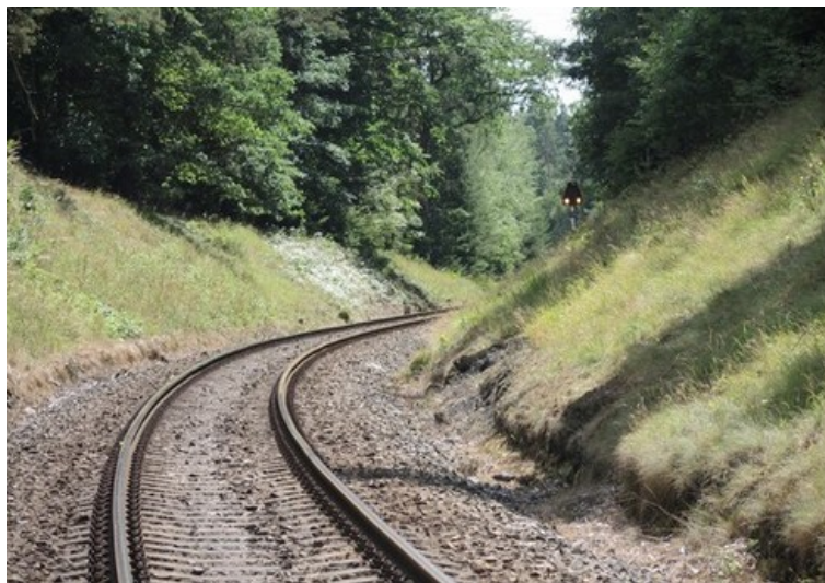
Obr. č. 4: Viditelnost kmenového přejezdníku X226 ze vzdálenosti 184 m Zdroj: DI
