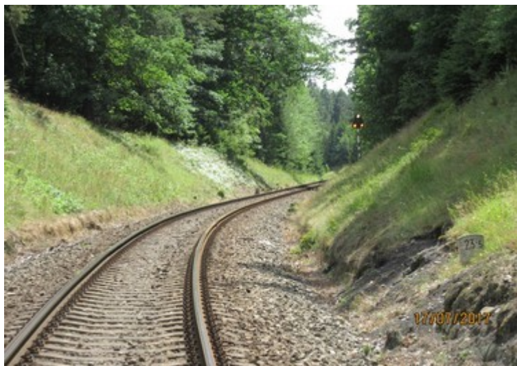
Obr. č. 5: Návěst „Uzavřený přejezd“ na kmenovém přejezdníku X226 Zdroj: DI
