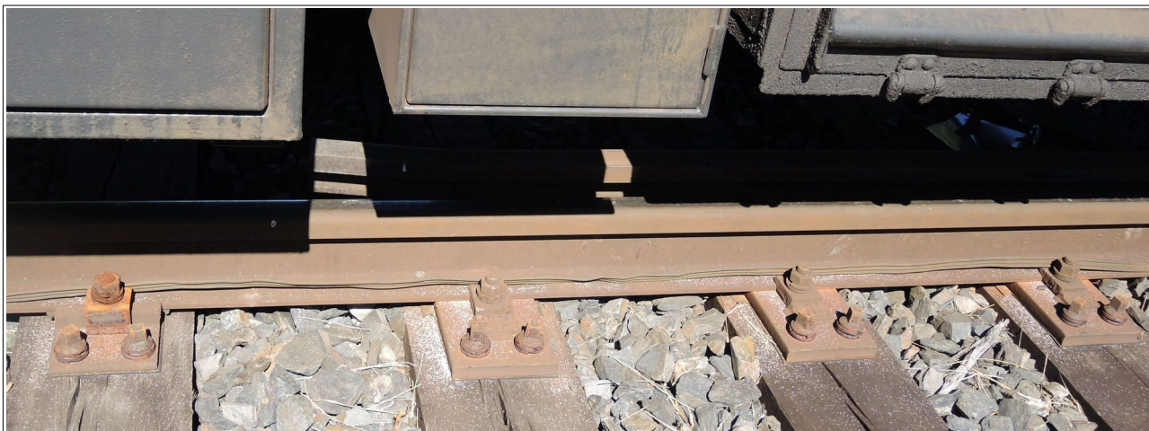
Obr. č. 9: Písek na patách kolejnice a pražcích pod TDV vlaku Služ 55025
