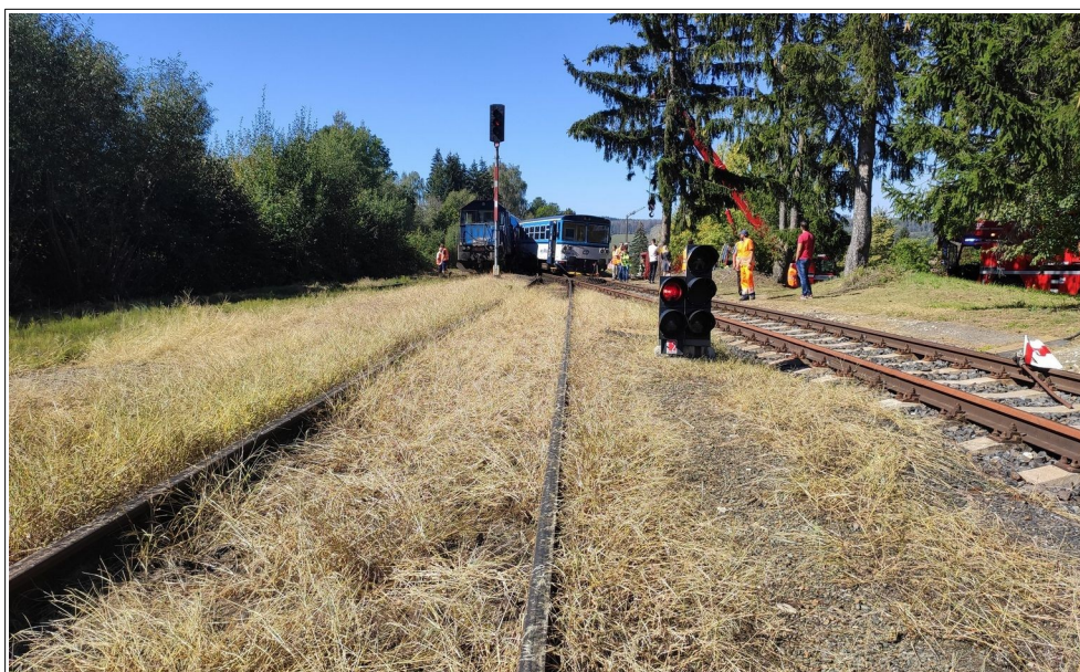
Obr. č. 4: Travnatý porost před a za úrovní návěstidla L2 žst. Kdyně
