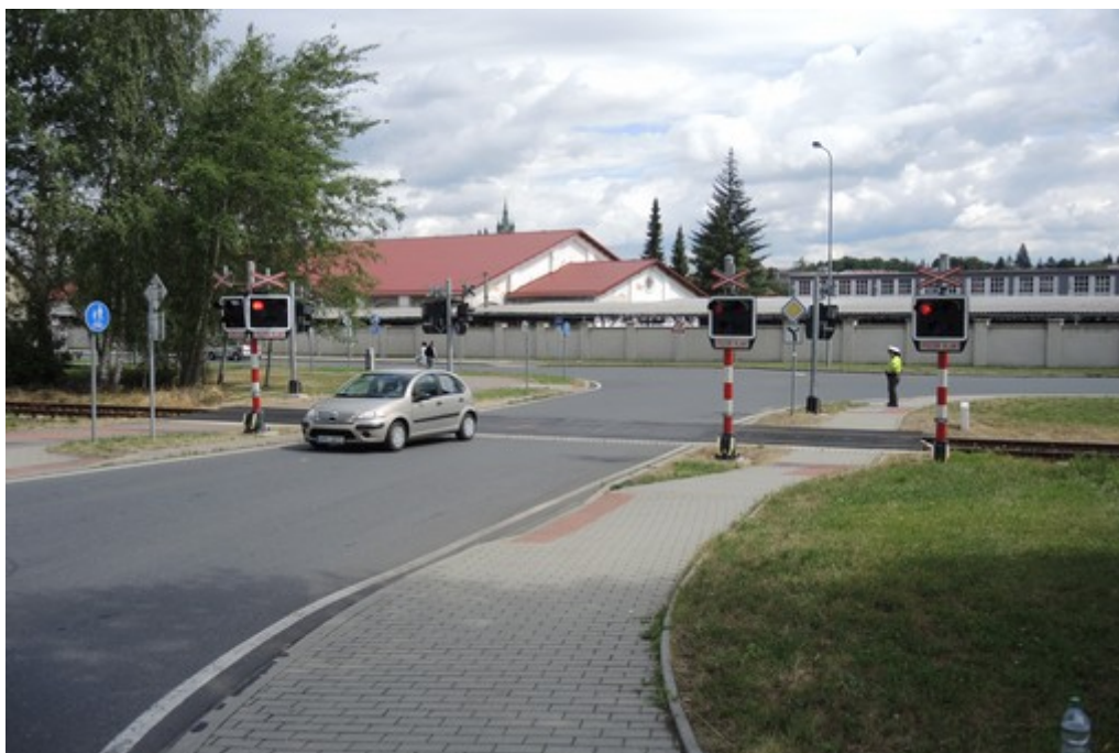
Obr. č. 7: Pohled na zabezpečení přejezdu P8385 z opačné strany
