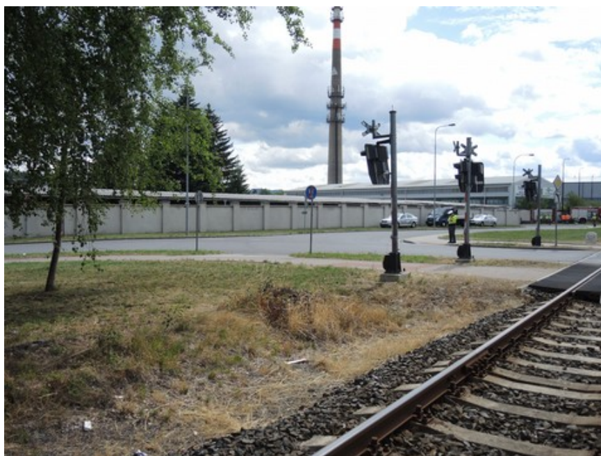
Obr. č. 6: Pohled ve směru jízdy vlaku Os 17505 k přejezdu
