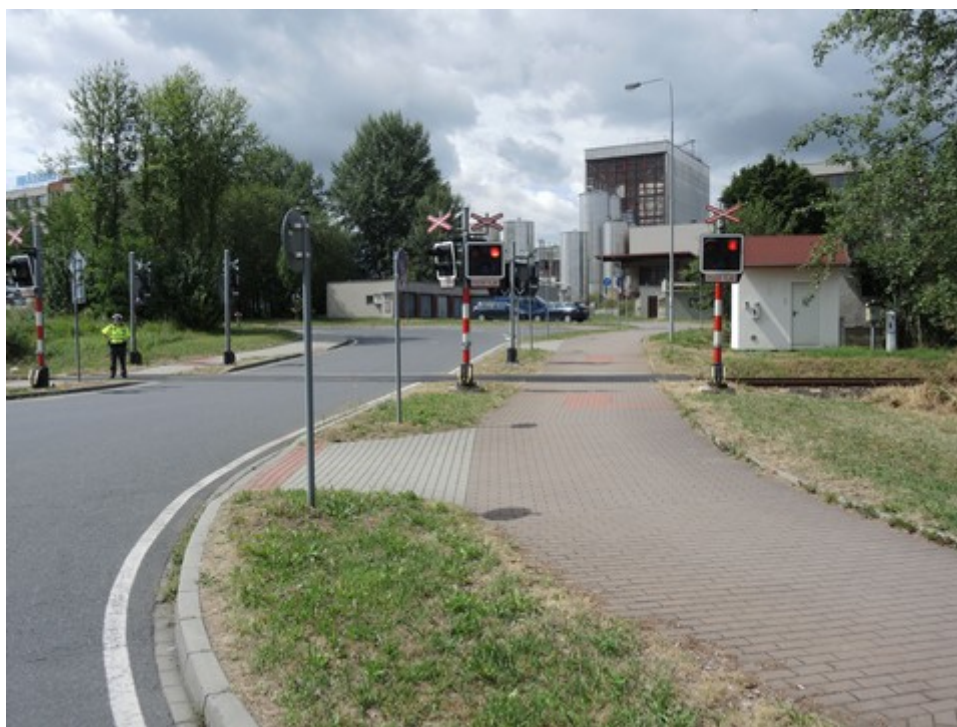
Obr. č. 1: Pohled na místo vzniku MU a zabezpečení přejezdu
