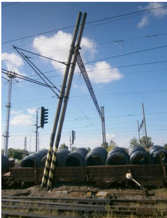
Obr. č. 13: Částečně vyvrácená trakční podpěra č. 80C.
