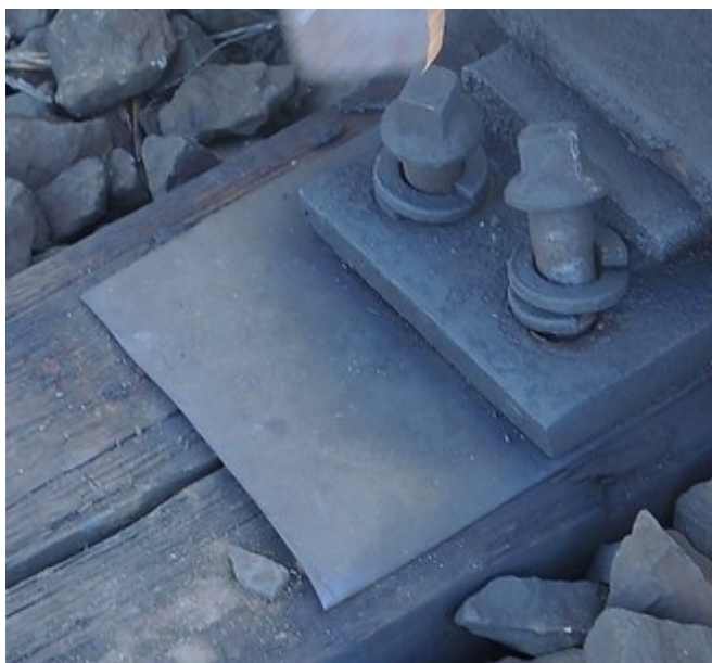
Obr. č. 9: Stav vrtulí levého pasu v bodě „+2“ uvnitř a vně koleje.
