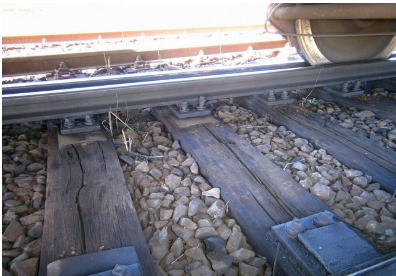
Obr. č. 12: Stav vrtulí a dřevěných pražců v místě propadu dvojkolí DV. Zdroj: SŽDC
