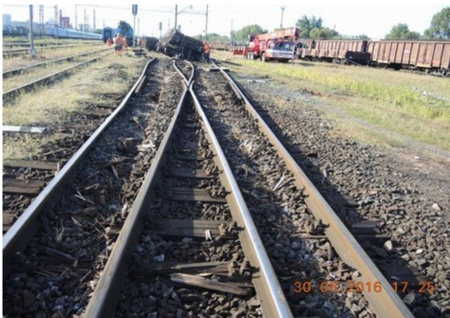
Obr. č. 14: Následky vykolejení na výh. č. 38 a kolejích č. 12 a 14.
