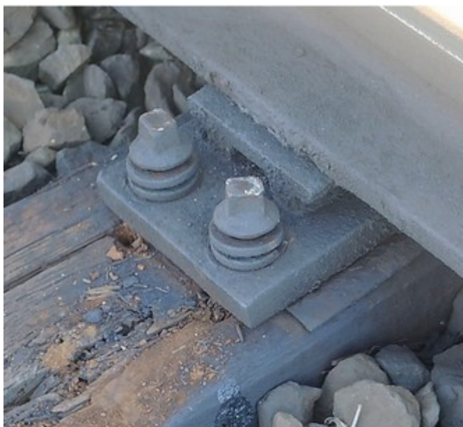
Obr. č. 10: Stav vrtulí levého pasu v bodě „+3“ uvnitř a vně koleje.
