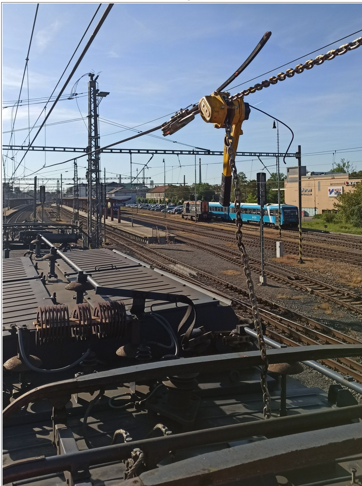
Obr. č. 4: Pohled na střechu HDV 163.244-7 a na TV upevněný řehťákový zvedák s volně visícím řetězem dotýkajícím se ližiny sběrače HDV po vzniku předmětné MU
