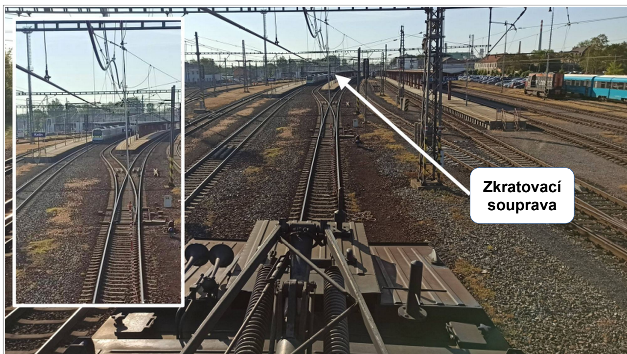
Obr. č. 5: Pohled na střechu HDV 163.244-7 a na TV před vznikem předmětné MU, kdy zkratovací souprava umístěná před pracovním místem ze strany od Záboří n. L. ve výměnném poli mechanického/elektrického dělení ÚO 441 byla připojena na levý trolejový drát ukotvený k TP č. 143 a 163 (ve výřezu je přiblížení jejího umístění)
