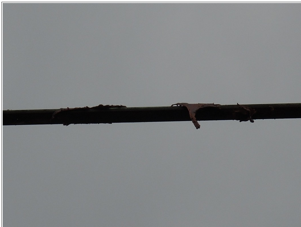
Obr. č. 5: Stopy na TV po zásahu montéra el. proudem
