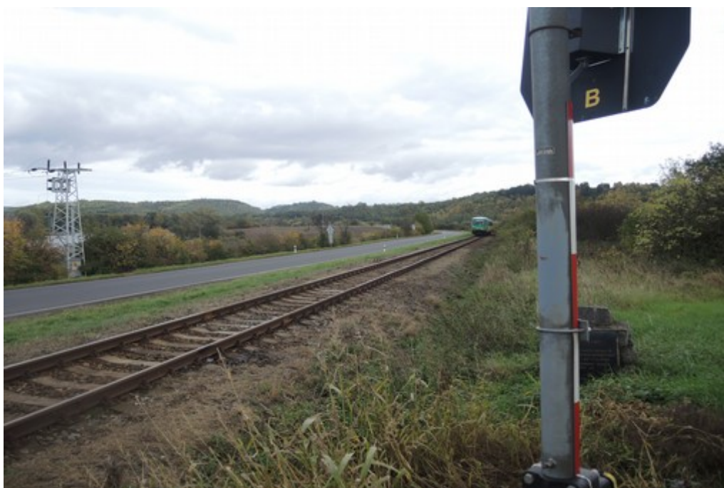
Obr. č. 5: Viditelnost blížících se DV k přejezdu od úrovně výstražníku
