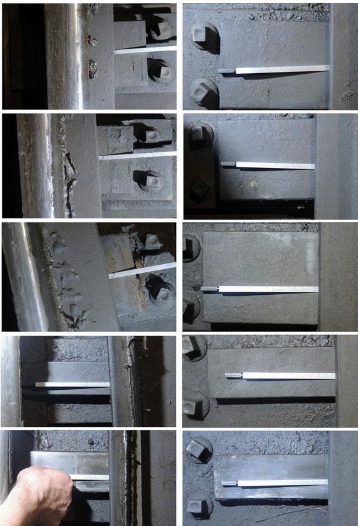
Obr. č. 5: Stav kluzných stoliček při ohledání místa MU (1. až 5. pražec).
