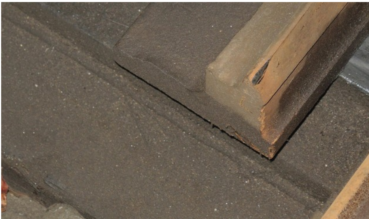
Obr. č. 3: Naražení vnitřní strany pravého jazyka výhybky č. 1sv okolkem kola HDV vlaku Os 8532. Zdroj: DI
