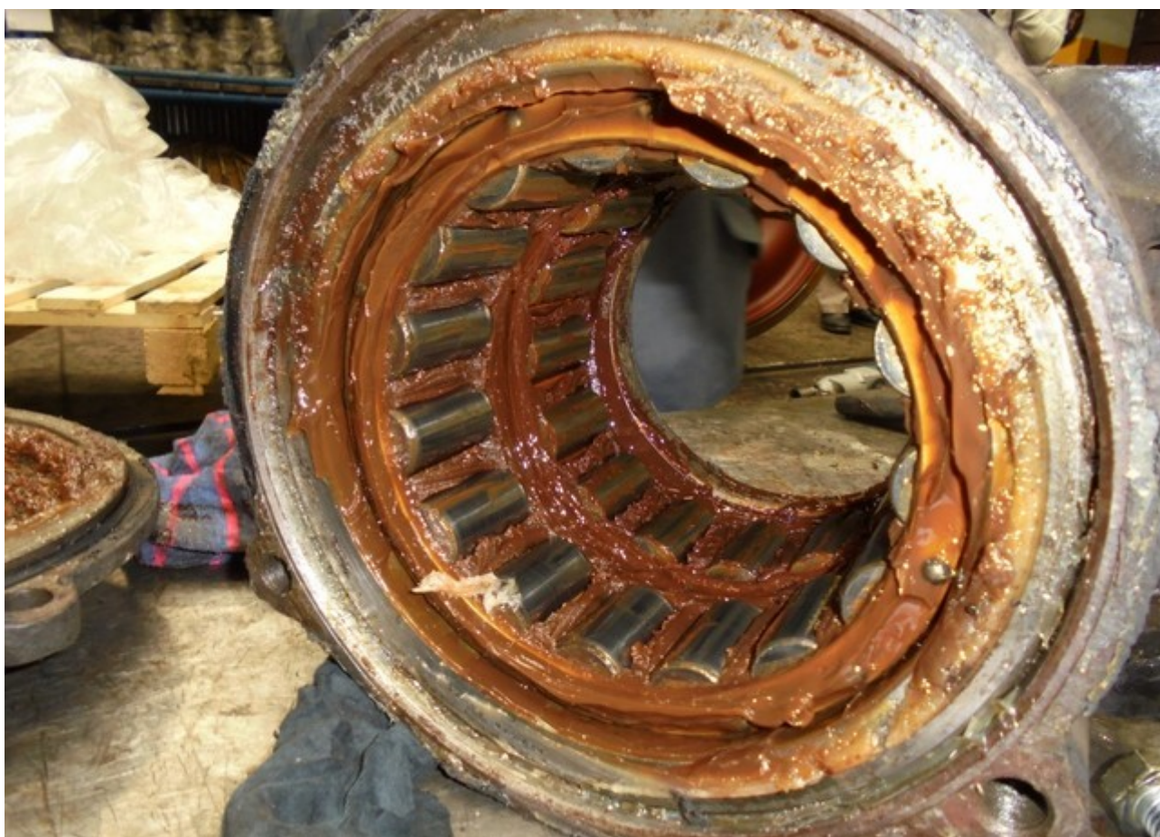
Obr. č. 10: Pravá ložisková komora 3. dvojkolí po vyjmutí zbytku ulomeného čepu
