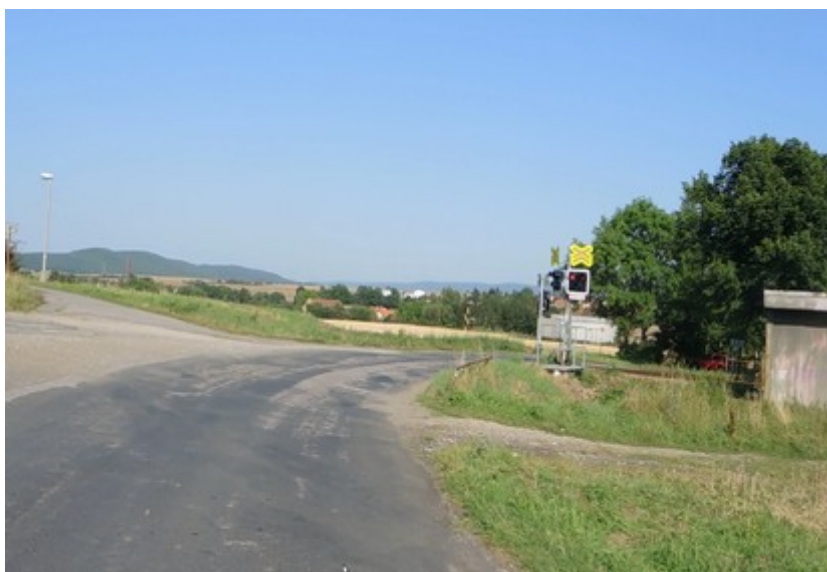
Obr. č. 7: Viditelnost výstražníku a výstrahy PZZ ze 40 m ve směru jízdy OA
