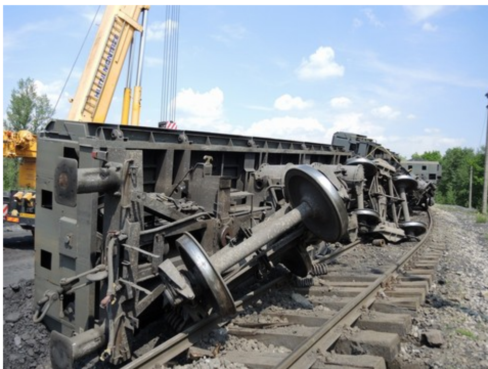
Obr. č. 6: Pohled na poškozený kolejový rošt koleje č. 6b a na vykolejené a vyvrácené 10. a 11. DV před HDV.
