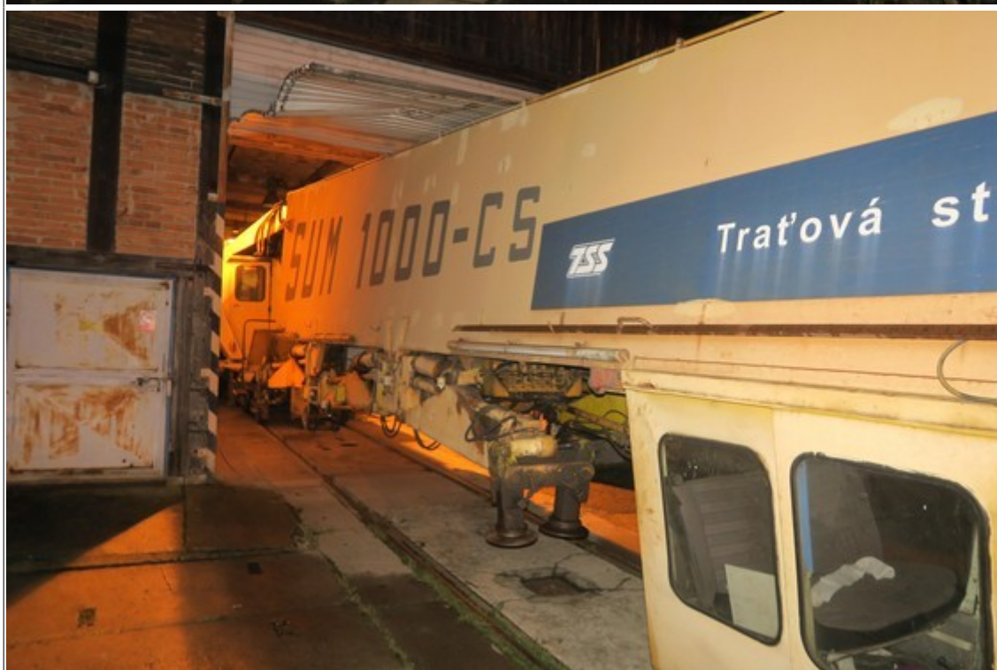
Obr. 7, 8: Pohled na SDV SUM 1000 v konečném postavení po vzniku MU – ze snímků je dobře patrné poškození zadních vrat haly Malá výtopna.
