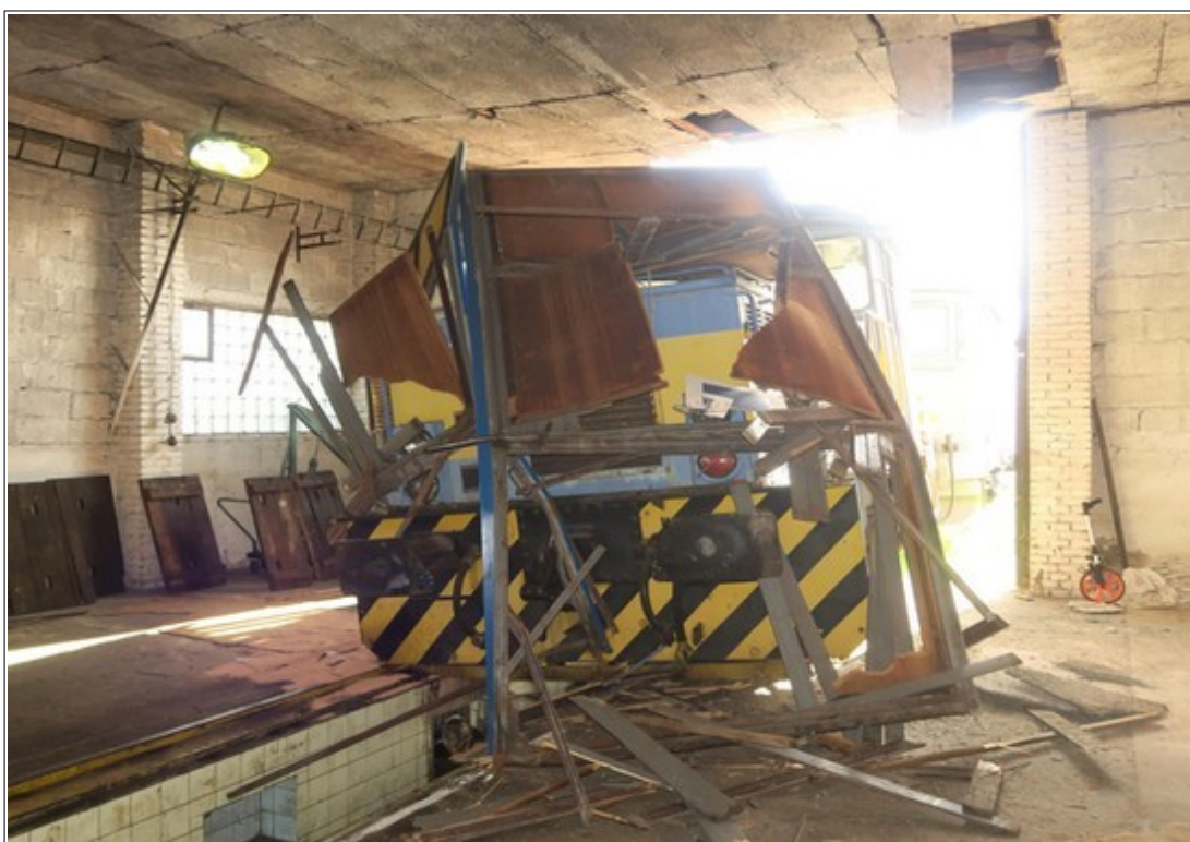
Obr. 9: Pohled na čelo posunového HDV 704.519-8 v konečném postavení po vzniku MU v místě poškození předních vrat budovy Malá výtopna.
