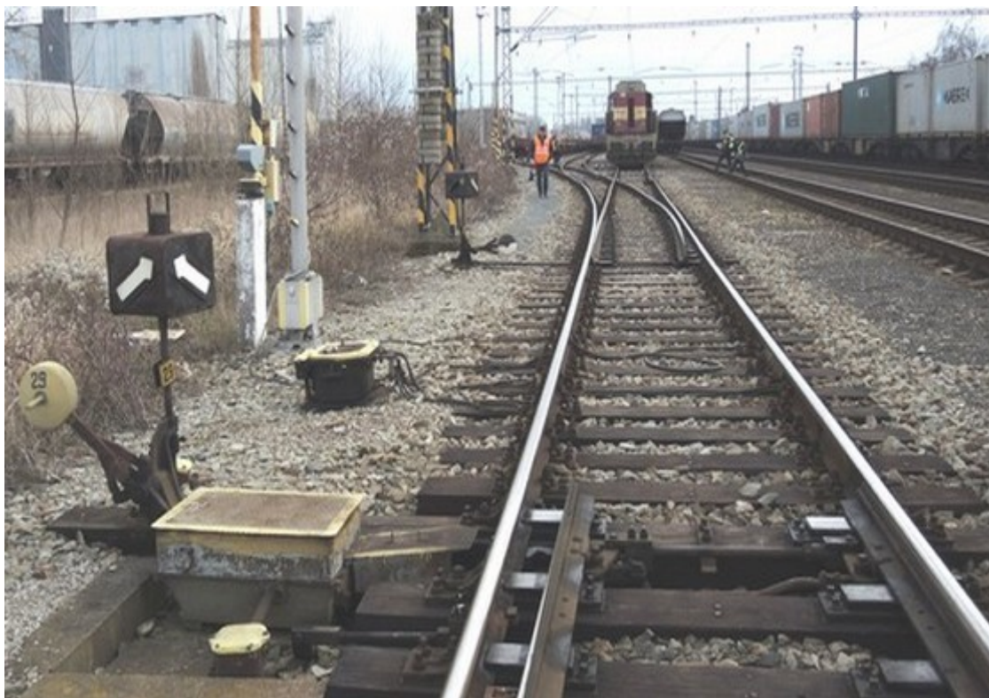
Obr. č. 5: Pohled na výhybky č. 29 a č. 26 a na HDV
