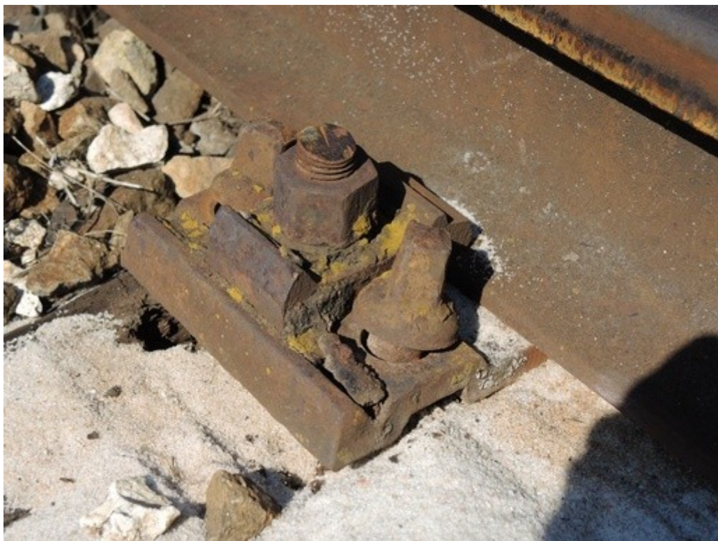
Obr. č. 8: Ukázka stavu vnitřního upevnění kolejnice ve vzdálenosti 25 m od vzniku MU
