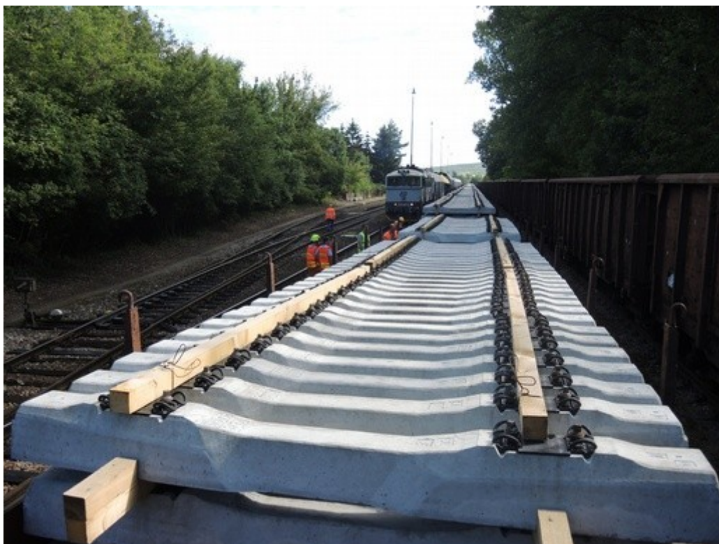
Obr. č. 6: Rovnoměrné rozložení nákladu vlaku Pn 68253, pohled na vykolejené 2. TDV
