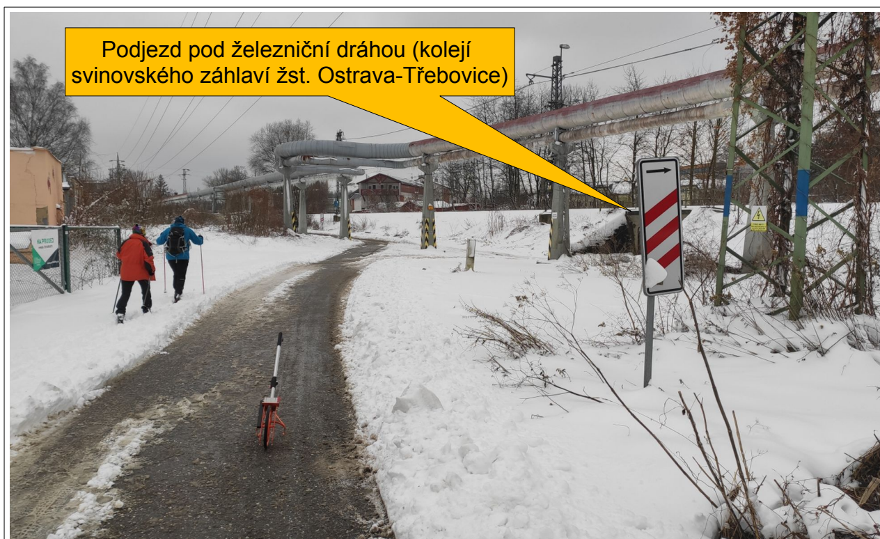
Obr. č. 7: Výstražná dopravní značka A 31a „Návěštní deska (240 m)“, nesprávně doplněná o směrovou šipku s vyobrazením šipky vpravo, umístěná ve vzdálenosti 240 m před ŽP P7724; chybí výstražná dopravní značka A 30 „Železniční přejezd bez závor“, která měla být umístěna nad dopravní značkou A 31a.
