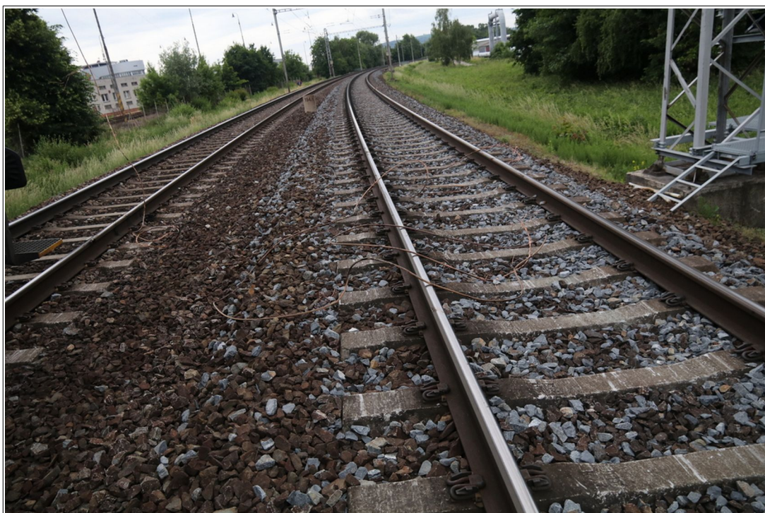
Obr. č. 16: Pohled na strženou část TV v prostoru TP č. 73 na kolejnicích obou kolejí napjedelského záhlaví žst. Otrokovice Zdroj: SŽ
