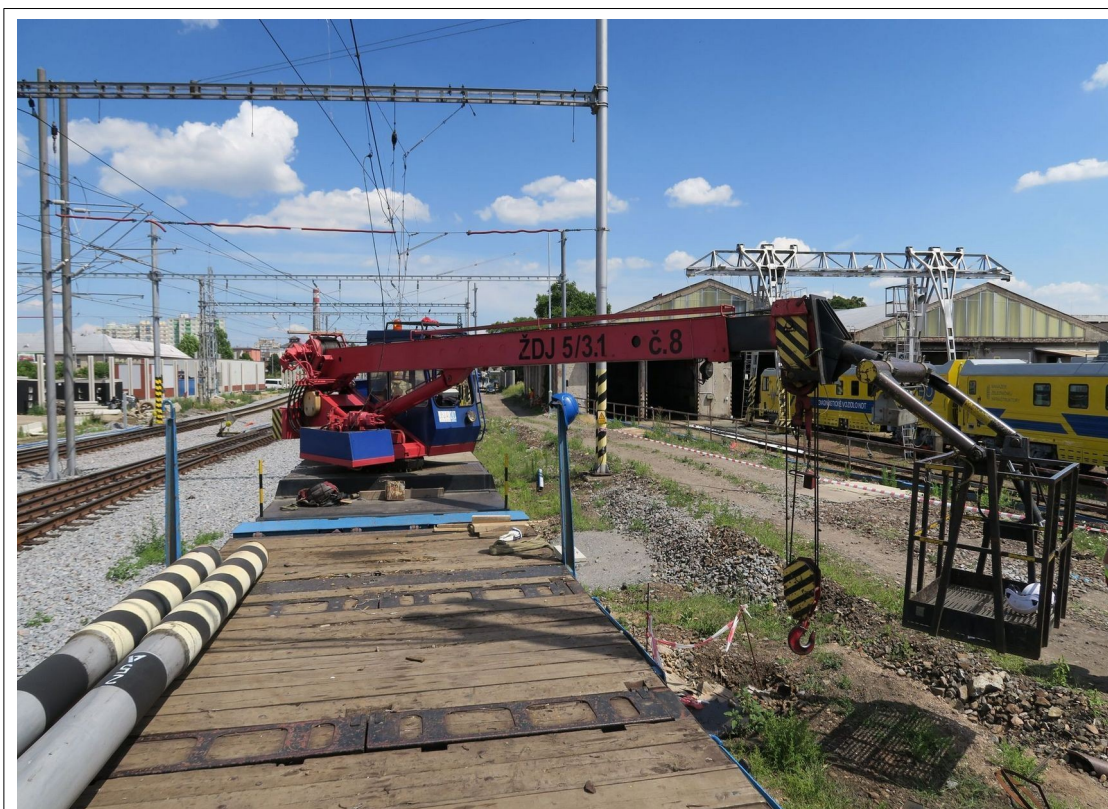
Obr. č. 5: Kolejový jeřáb ŽDJ 5/3.1 s jeřábovou nástavbou AD 10
