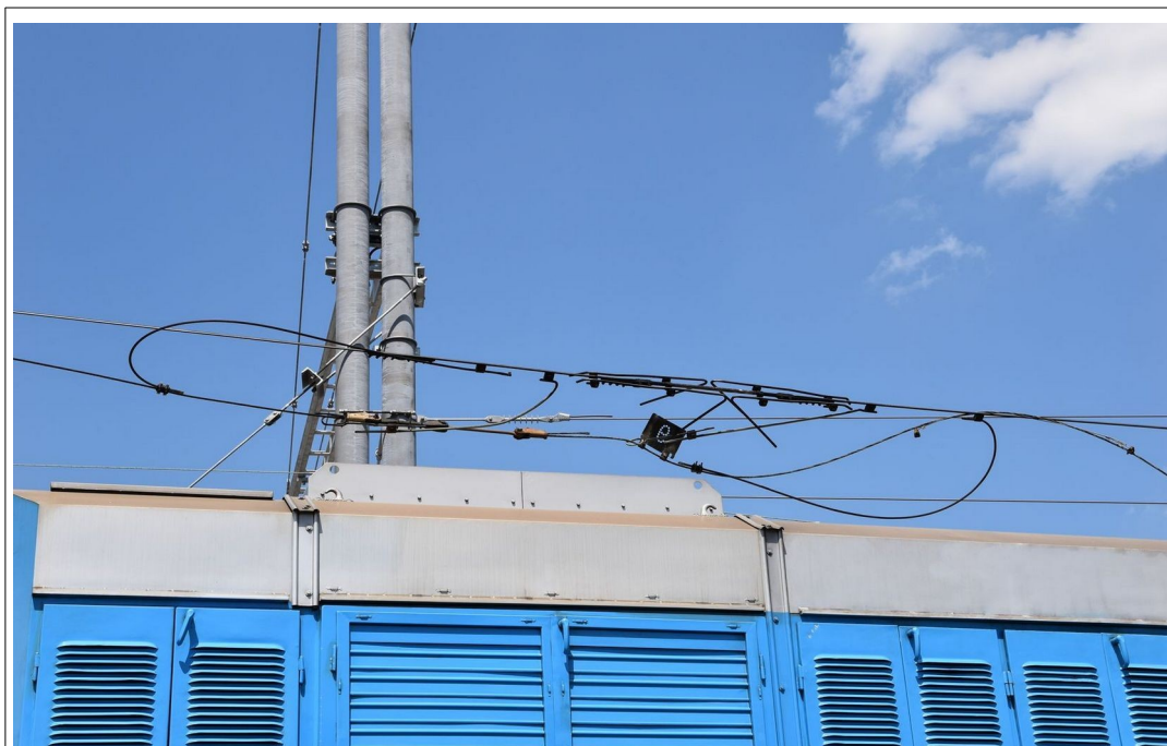
Obr. č. 9: Pohled na ÚD č. 6 TV nad HDV
