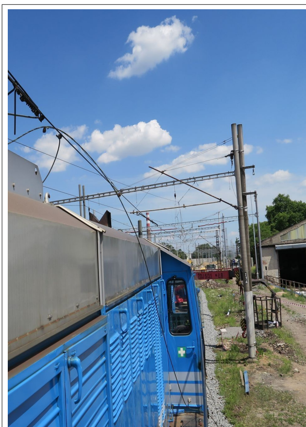
Obr. č. 8: Pohled na údajně nebezpečně nahnutý stožár TV Zdroj: DI
