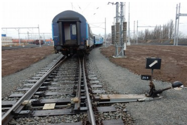
Obr. č. 6: Výhybka č. 253 přestavena směrem na SK č. 923
