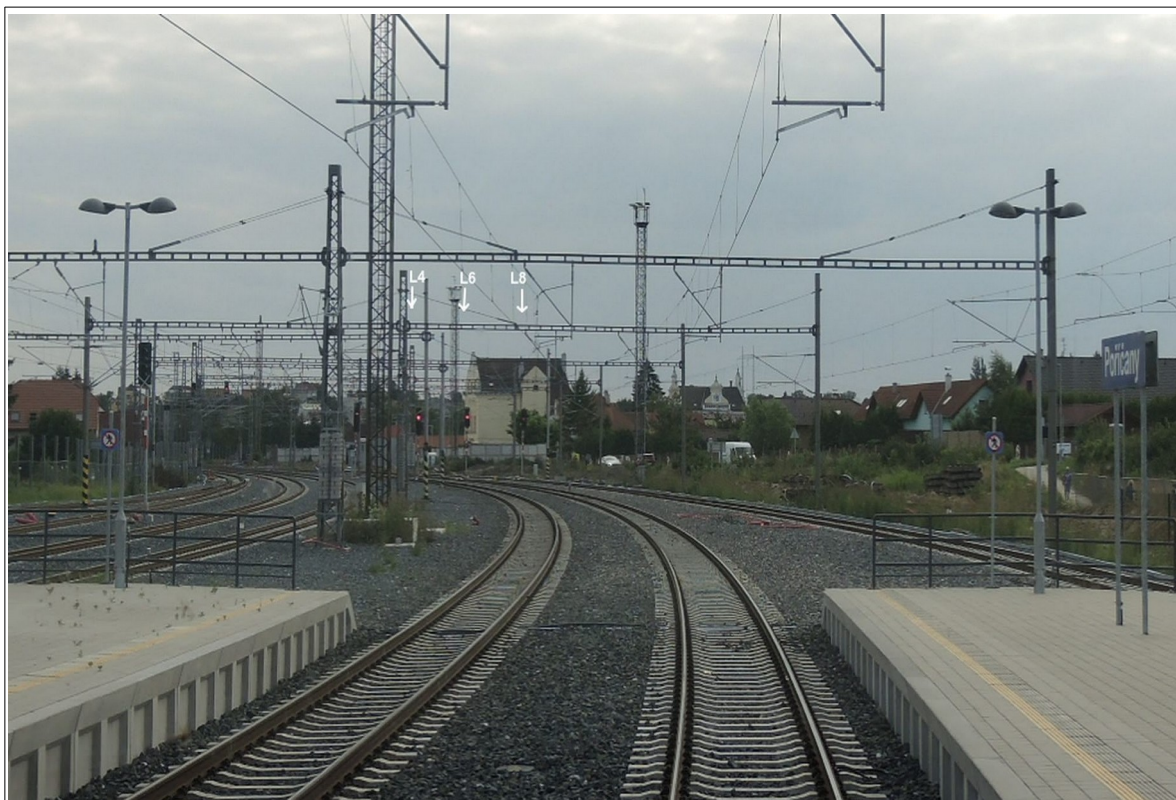
Obr. č. 6: Pohled na návěstidlo L6 ze stanoviště strojvedoucího vlaku ze 6. SK, s možností počítání návěstidel zprava Zdroj: DI
