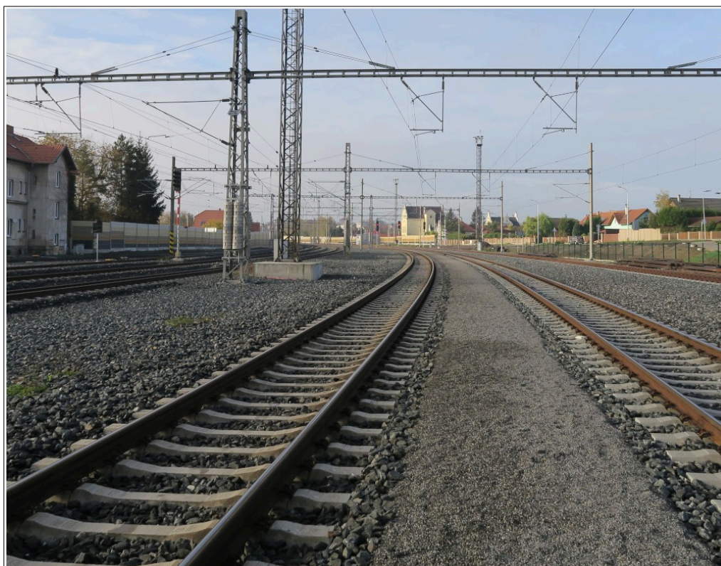
Obr. č. 3: Viditelnost odjezdového návěstidla L4 na vzdálenost 200 m
