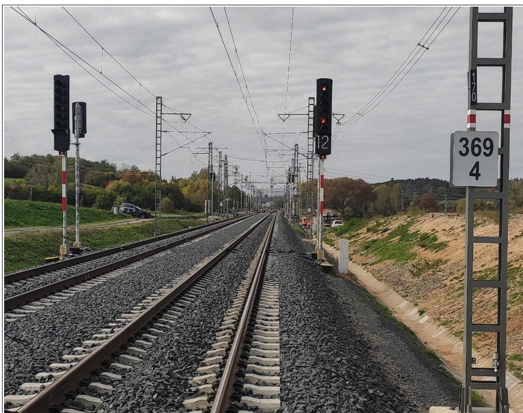
Obr. č. 9: Pohled na vjezdové návěstidlo 2L žst. Poříčany
