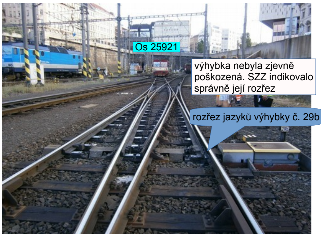
Obr. č. 3: Pohled na rozřez výhybky č. 29b
