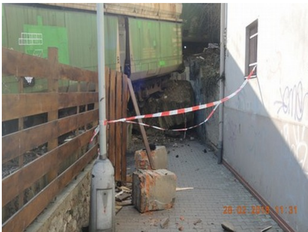
Obr. č. 4: Pohled do veřejně přístupného podchodu
