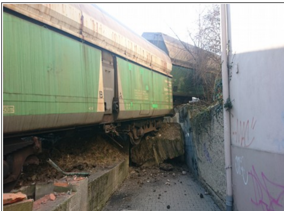
Obr. č. 1: Pohled na vykolejené vozy v podchodu
