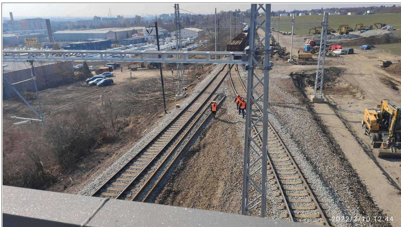
Obr. č. 7: Pohled na místo MU od návěstidla 1L Odbočky Skály umístěného na návěštní lávce – vlevo po 1. TK nedovoleně projel vlak Nex 60204, na kolej vpravo byla postavená vlaková cesta vlaku Mn 85012, který měl jet směrem k objektivu fotoaparátu. V pozadí je staveniště se snesenou 2. a 101. traťovou kolejí Zdroj: DI
