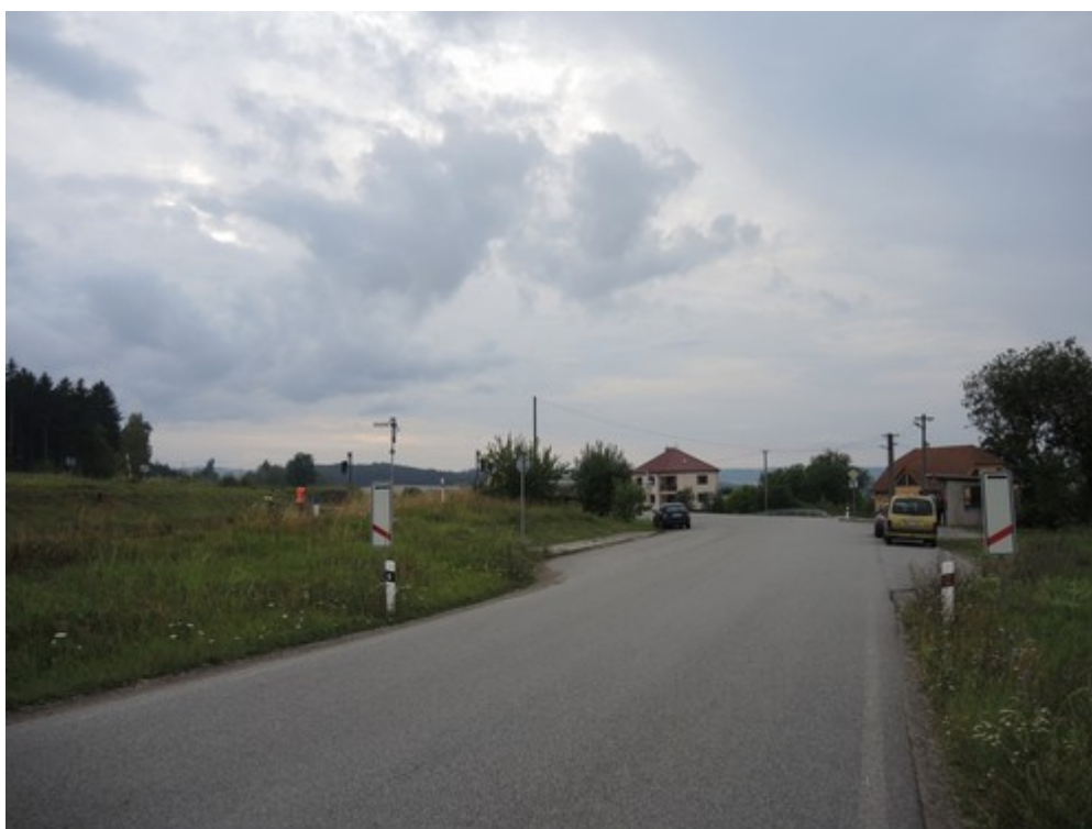
Obr. č. 7: Pohled na dopravní značky A 31c „Návěstní deska (80 m)“ ve směru od obce Stařeč
