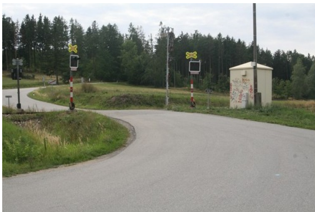
Obr. č. 5: Pohled na označení přejezdu ve směru od obce Stařeč, to na vzdálenost větší než Dz = 20 metrů Zdroj: DI
