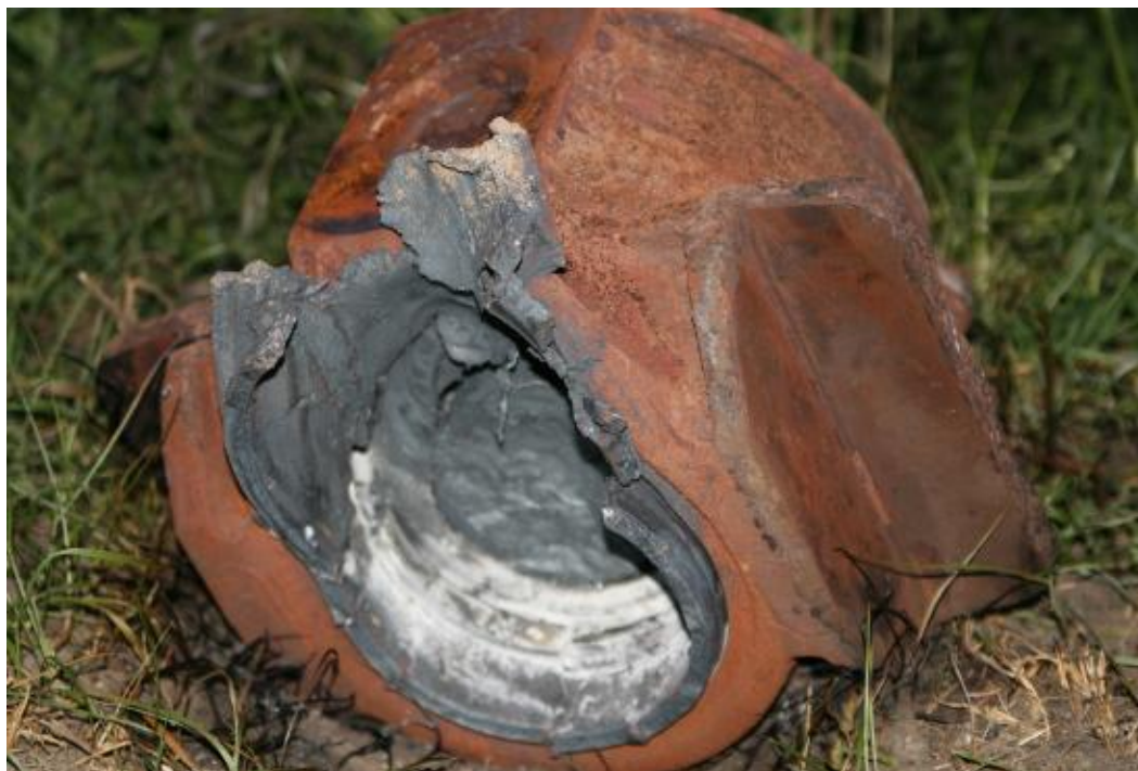
Obr. č. 6 : Detail tohoto ložiskového domku
