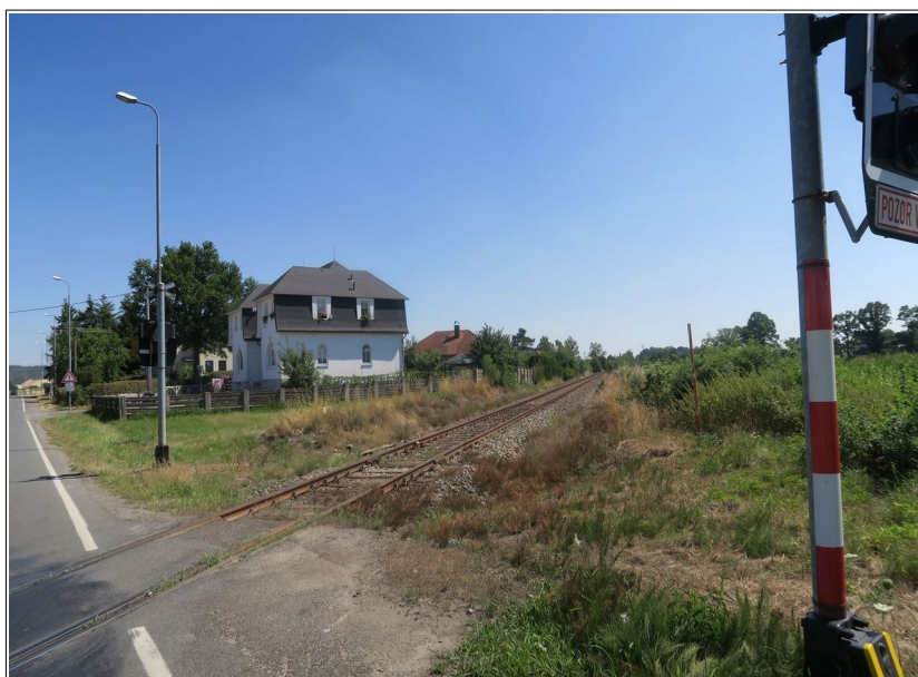
Obr. č. 5: Rozhledová délka L_p ve směru jízdy OA a vlaku Os 7214
