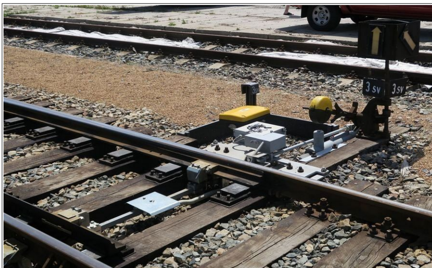
Obr. č. 3: Výhybka č. 3sv
