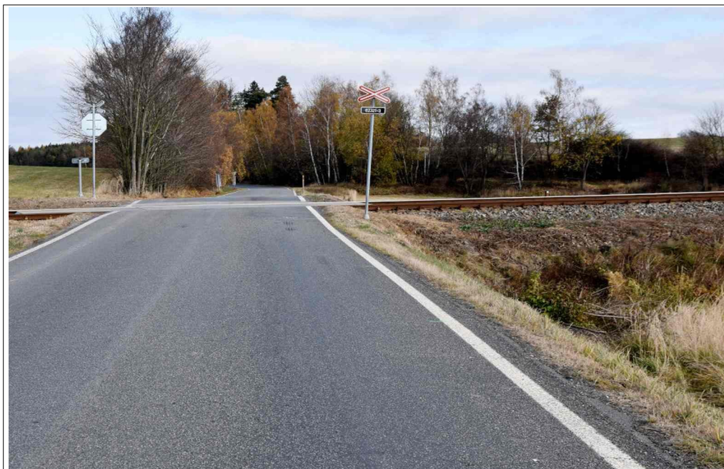
Obr. č. 2: Výhled na VK z rozhledové délky pro zastavení ( D_z ) ve směru jízdy NA. Zdroj: DI
