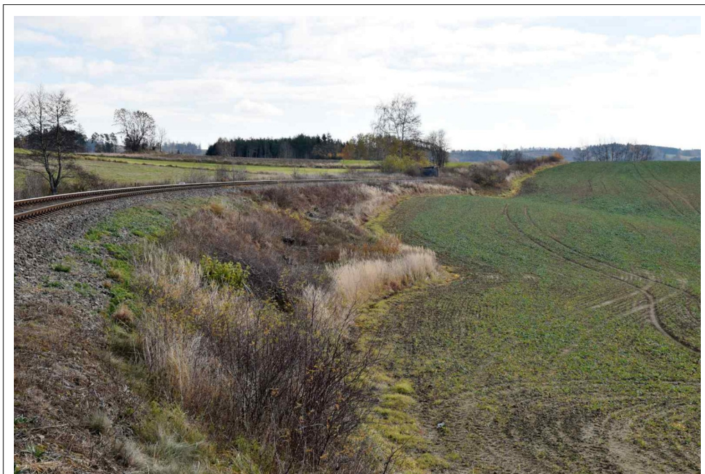
Obr. č. 4: Rozhledová délka pro nejpomalejší silniční vozidlo ( L_p ) ze směru jízdy vlaku. Zdroj: DI
