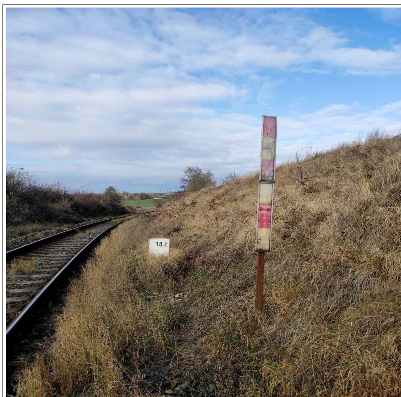
Obr. č. 5: „Výstražný kolík“ ve směru jízdy vlaku. Zdroj: DI
