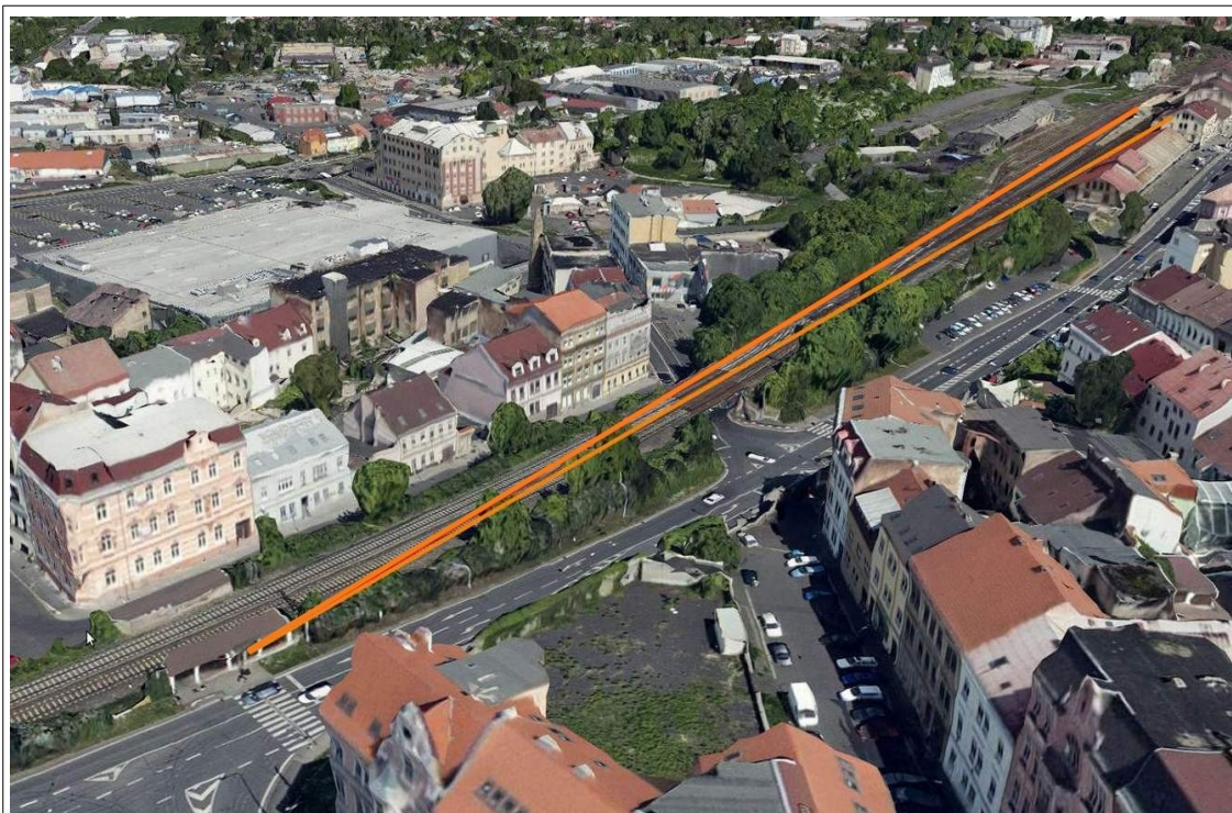
Obr. č. 7: Úzký kužel světla silničního semaforu křižovatky ulic Na Hrázi a Dubská pronikající do prostoru nástupišť žst. Teplice v Čechách. Zdroj: Google maps
