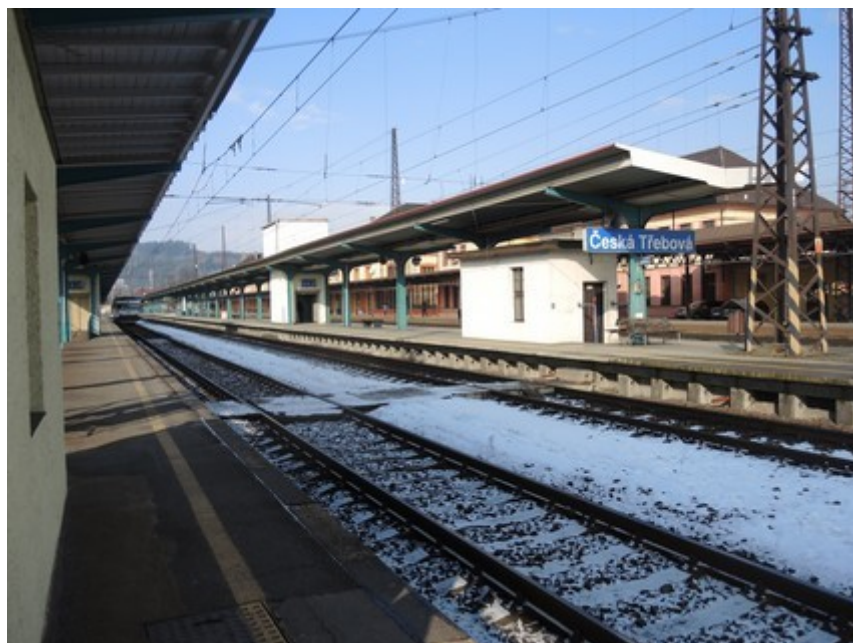
Obr. č. 23: Pohled na 2. nástupiště z přechodného stanoviště výpravčího
