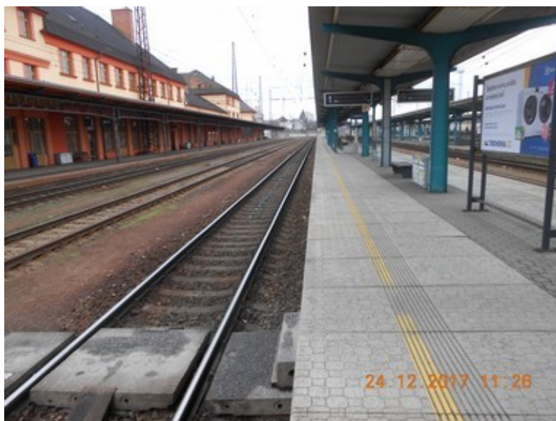
Obr. č. 21: Druhé nástupiště, 12. SK v žst. Česká Třebová Zdroj: DI
