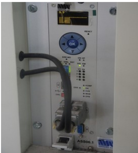
Obr. č. 16: Protismykový regulátor
