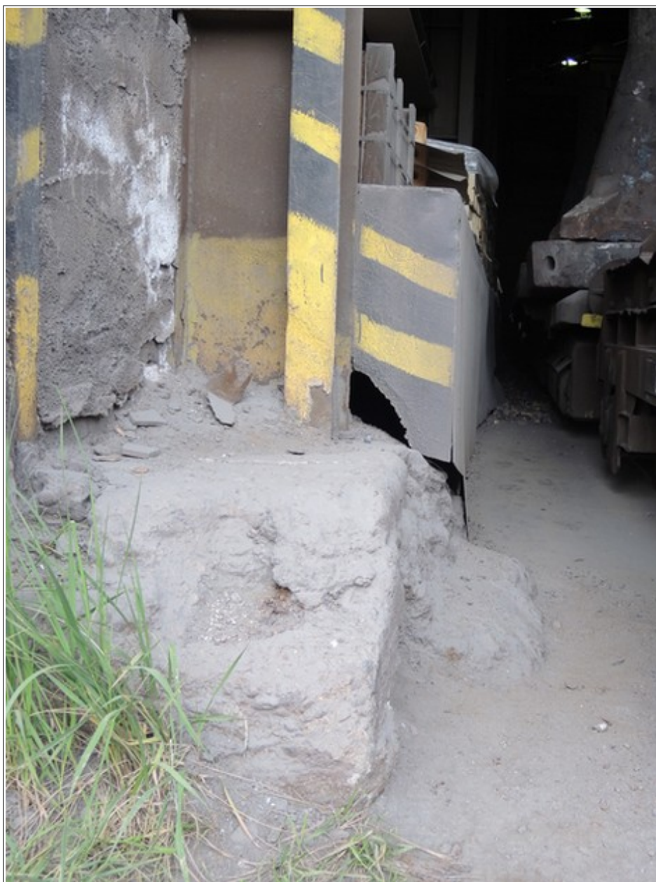
Obr. č. 9: Prostor za rolovacími vraty v hale ÚLD. V popředí patka stožáru nosíku a pevná nerovnoměrná terénní nerovnost neoznačená bezpečnostními značkami. Zdroj: DI
