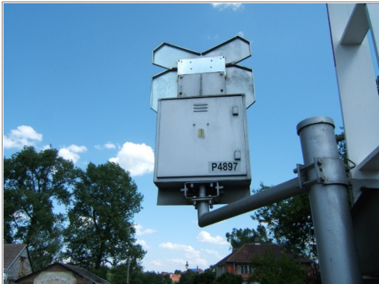
Obr. č. 3: Pohled na označení přejezdu P4897
