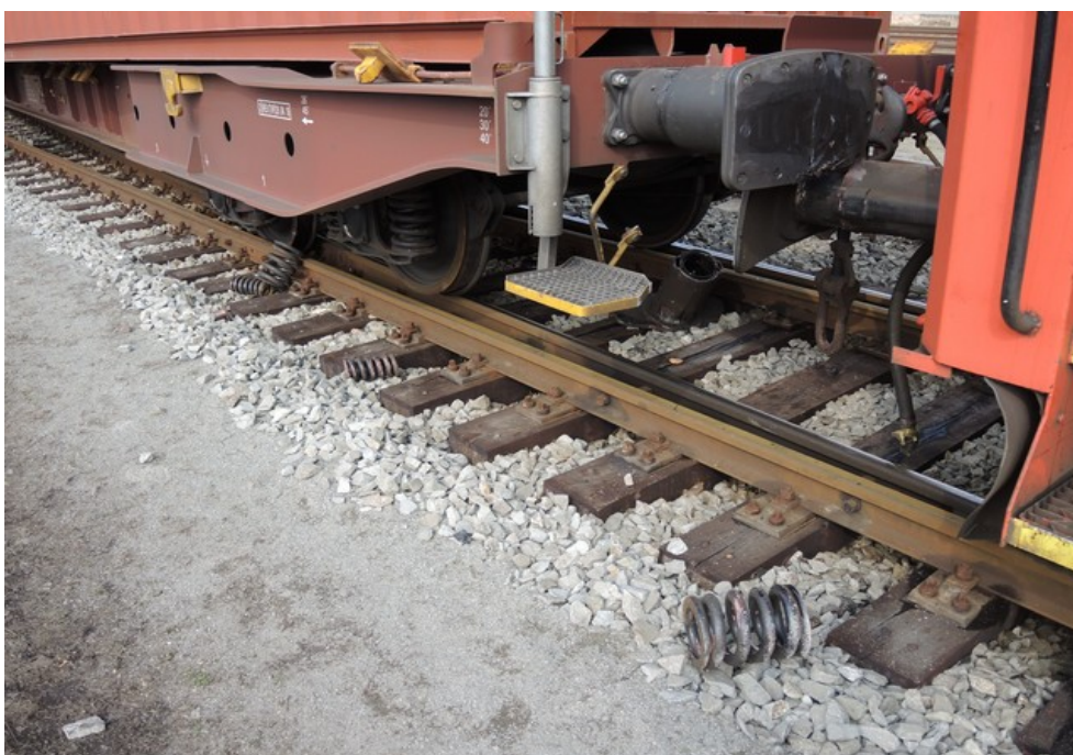
Obr. č. 13: Zaklesnutí nárazníků sražených posunových dílů Zdroj: DI
