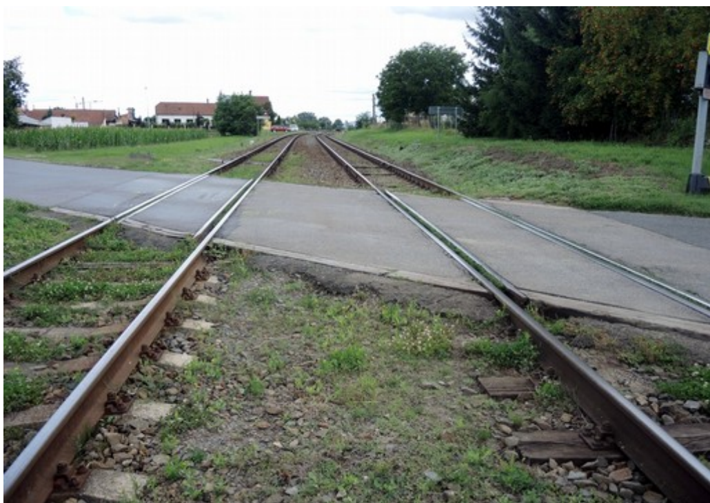
Obr. č. 8: Přejezdová vozovka
