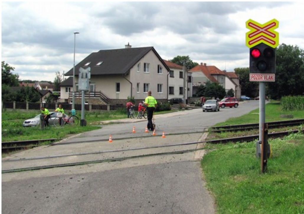
Obr. č. 3: Stav přejezdu ve směru jízdy OA po příjezdu pověřené osoby provozovatele dráhy a dopravce na místo MU
