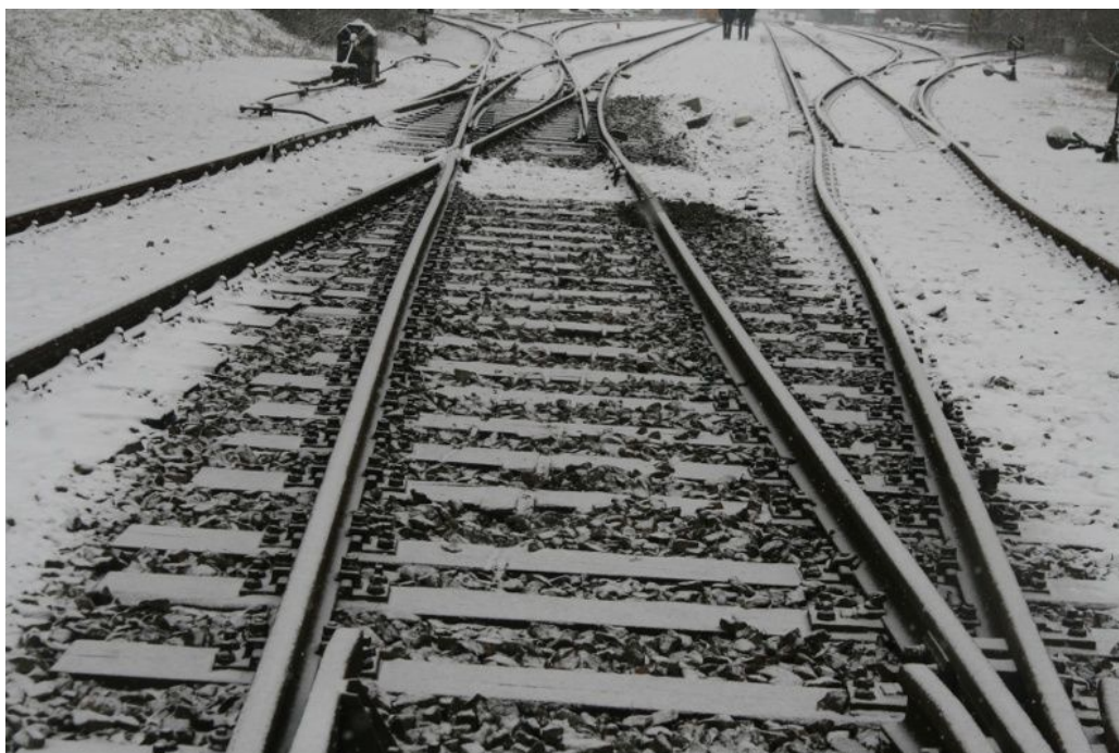
Obr. č. 7: Stopy vykolejení a vybočení koleje ve směru jízdy vlaku po odstranění vykolejených DV
