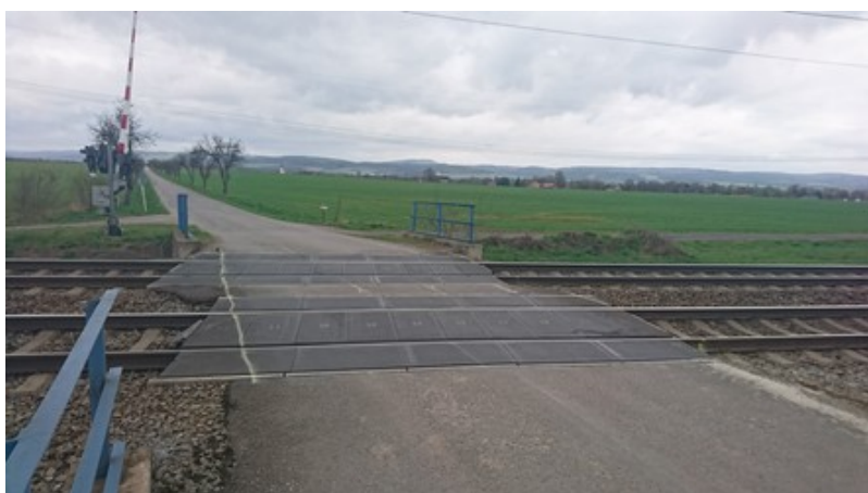
Obr. č. 19: Pohled na stavební provedení přejezdu P6519 Zdroj: DI
