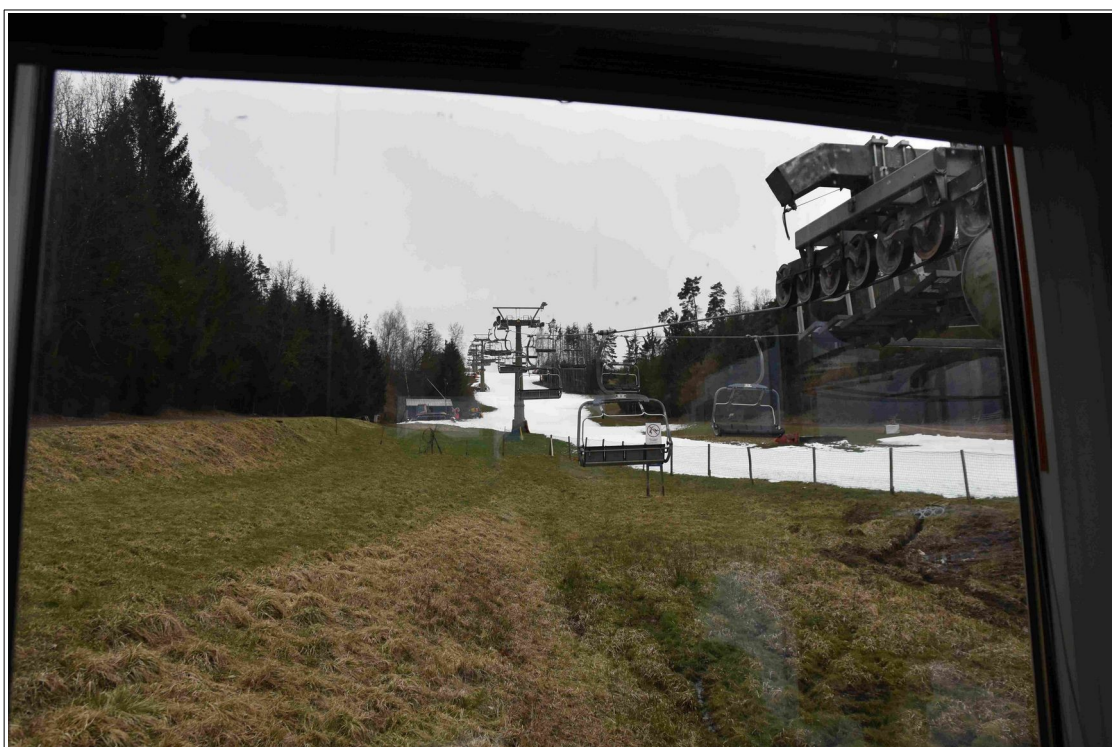
Obr. č. 3: Výhled na trať LD z okna velína dolní stanice (foceno vsedě ze židle obsluhy)
