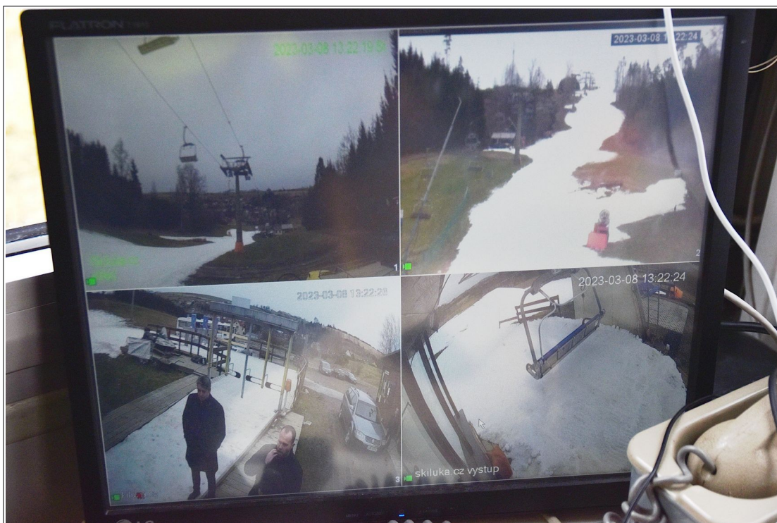
Obr. č. 5: Pohled na monitor pracovníka obsluhy LD umístěný na kancelářském stole v místnosti velína, s on-line snímky zachycujícími jednotlivé části LD Zdroj: DI
