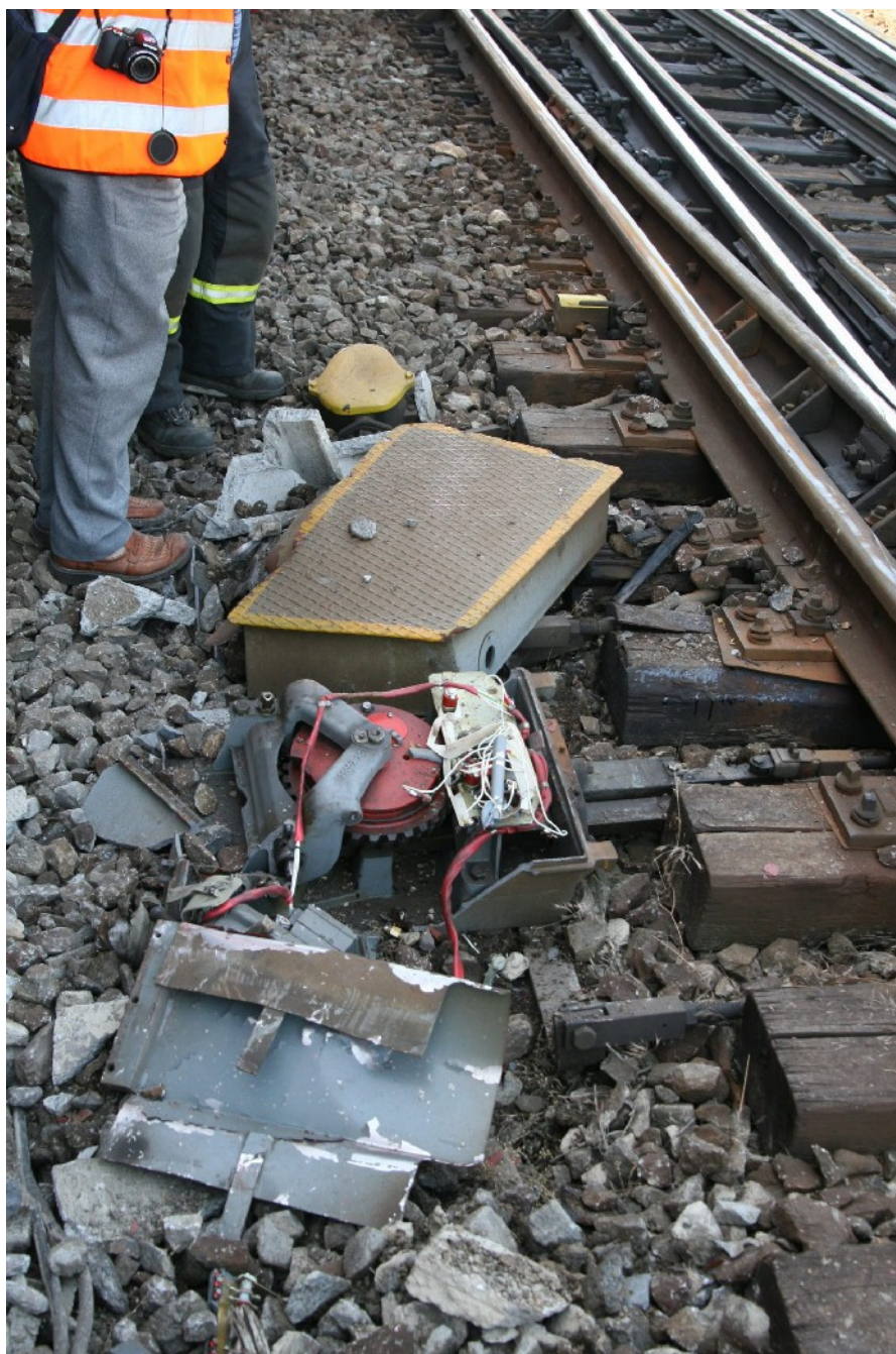
Foto 5: Zničený elektromotorický přestavník
