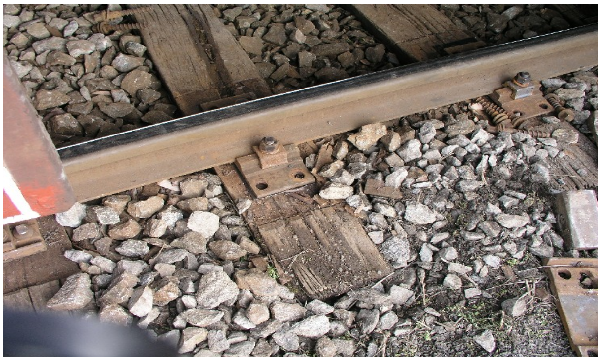
Foto 5: Chybějící upevňovací prvky v místě vykolejení v pravém kolejnicovém pásu
